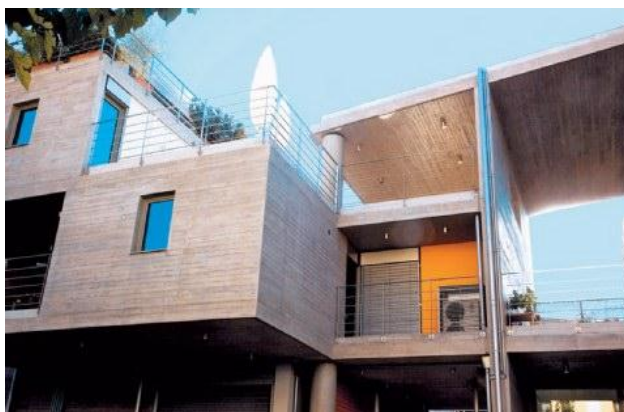
Συγκρότημα κατοικιών στο Μεταξουργείο.
