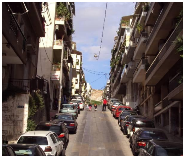
Αγίας Ζώνης. Μεγάλα ύψη κτιρίων σε σχέση με το πλάτος του δρόμου.
