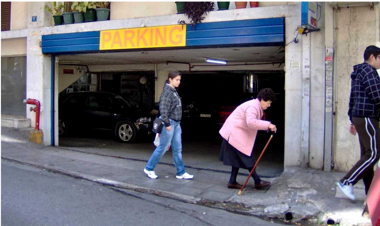
Οδός Κεφαλληνίας. Το γέμισμα της υδρορροής για κάποιες κατηγορίες πολιτών, μπορεί να είναι ένα τεράστιο εμπόδιο.
