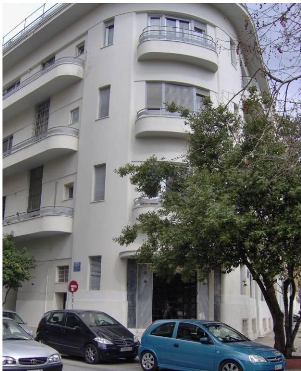
Φ. Νέγη και Επτανήσου η χαρακτηρισμένη ως διατηρητέα πολυκατοικία Λαναρά, έργο του μηχανικού Ι. Ζολώτα.
