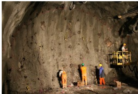
Εικόνα 3.2: Βόρειο μέτωπο - Α φάση (Ασβεστόλιθος)/ γόμωση για εκσκαφή με χρήση εκρηκτικών υλών [21]
