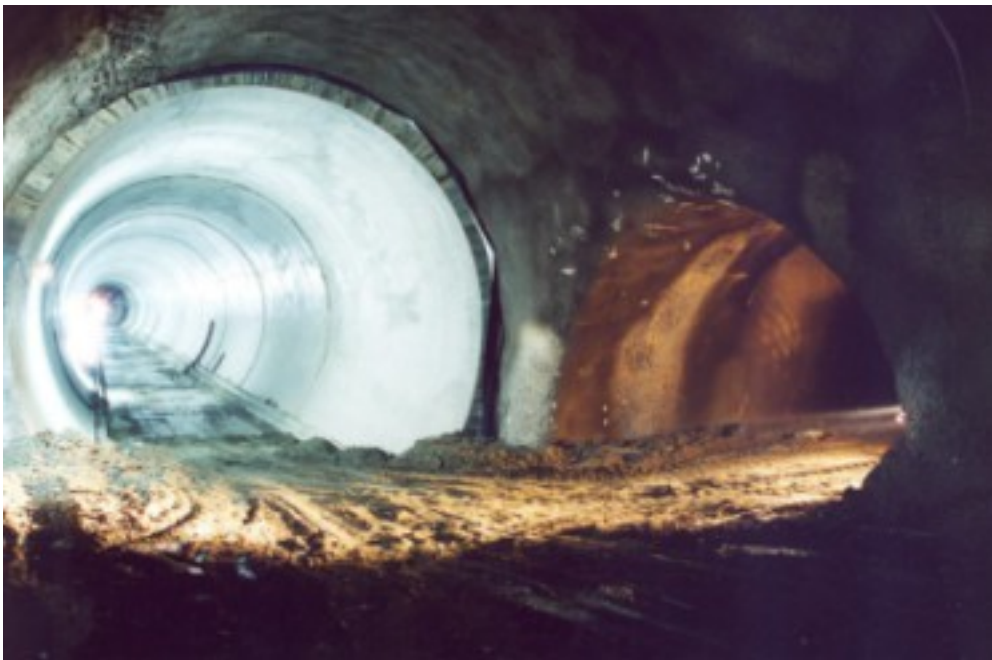
Εικόνα 3.1: Σήραγγα Καλλιδρόμου: Συνδετήρια Σήραγγα υπο κατασκευή [21]
