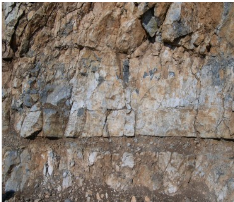
Εικόνα 2.4: Διακλάσεις και επιφάνειες σχιστότητας στην ασβεστολιθική ανθρακική ενότητα (kj) στην βόρεια περιοχή του Καλλιδρόμου [17]
