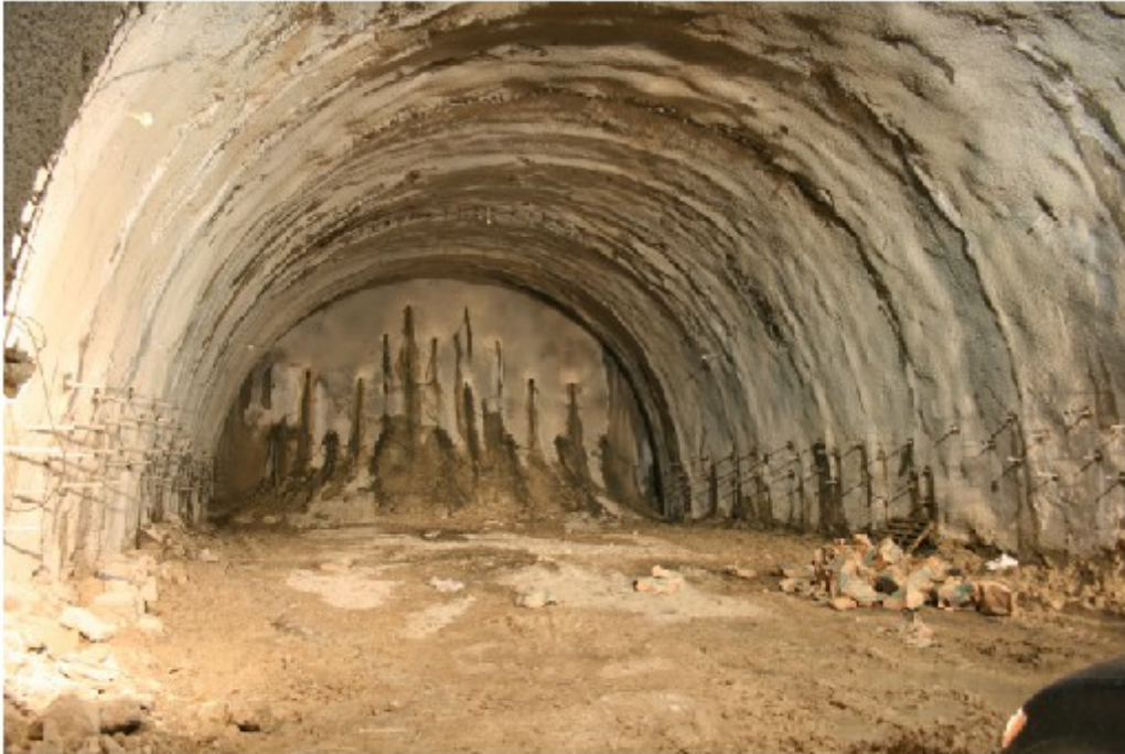
Εικόνα 3.3: Νότιο μέτωπο - Αργιλικός σχηματισμός, Άκαμπτη Υποστήριξη Α' Φάση [21]
