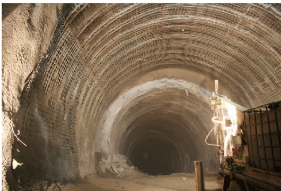
Εικόνα 4.7: Νότιο μέτωπο - Σχιστώδης Σερπεντινίτης, Ολική ανακατασκευή διατομής [21]
