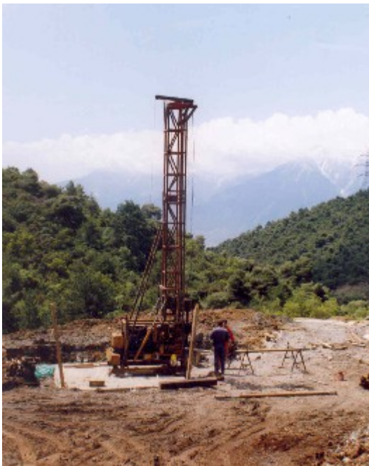
Εικόνα 2.7: Ερευνητική Γεώτρηση KT5 και δειγματοληψία( Βάθος: 458,30m - 463,20m, Σχιστώδης Σερπεντινίτης [17])
