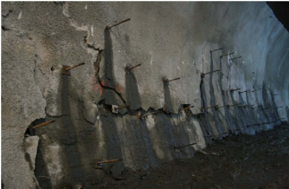
Εικόνα 4.5: Νότιο μέτωπο - Σχιστώδης Σερπεντινίτης, Εκτεταμένες επιπρόσθετες υλώσεις [21]
