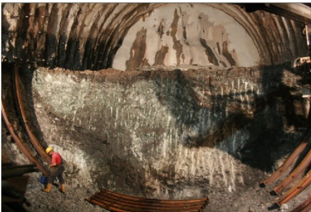
Εικόνα 4.6: Νότιο μέτωπο - Σχιστώδης Σερπεντινίτης, Τοποθέτηση πλαισίων [21]
