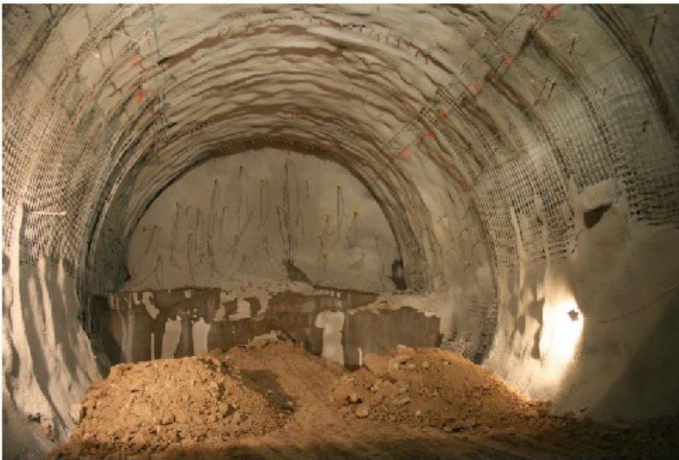
Εικόνα 3.5: Νότιο μέτωπο - Αργιλικός σχηματισμός, Άκαμπτη Υποστήριξη - Οπλισμοί [21]
