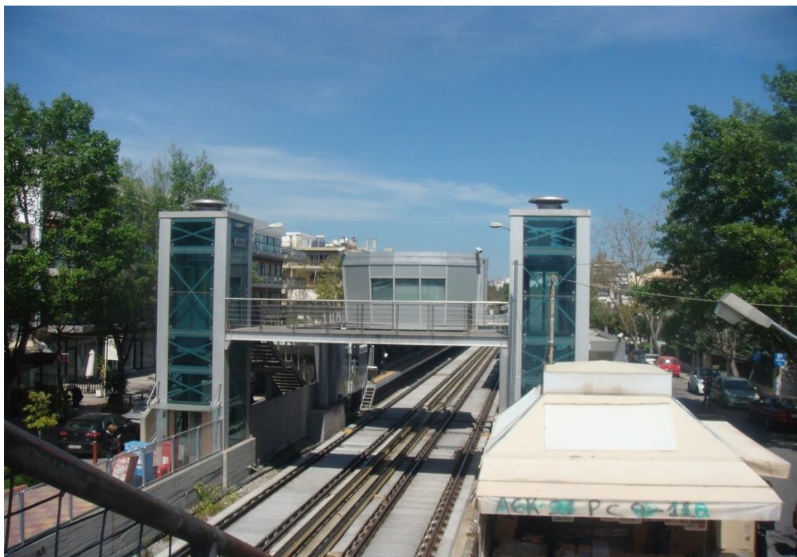
Εικόνα 6.2.4.3.1 Πεζογέφυρα σταθμού ΚΑΤ 78
