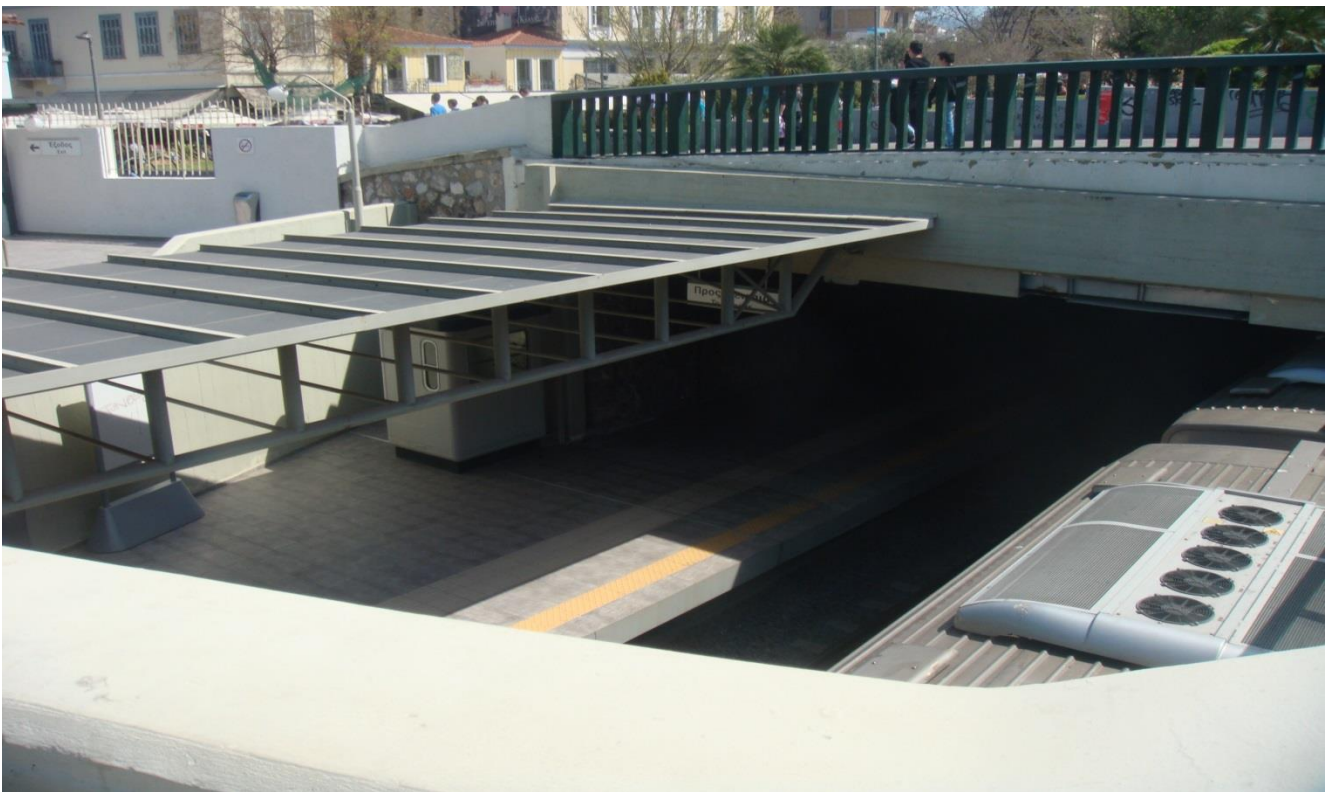
Εικόνα 6.2.4.2.2 Μεταλλικό στέγαστρο, όψη πάνω από την πεζογέφυρα 77
