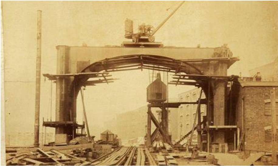
Εικόνα 5.5.2 Ατμομηχανή που κινούσε τον ανυψωτικό μηχανισμό. 48
