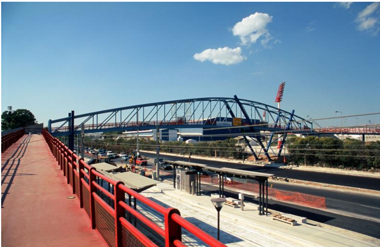
Εικόνα 6.2.6.1 Άποψη από την παραλία-κατασκευή 81
