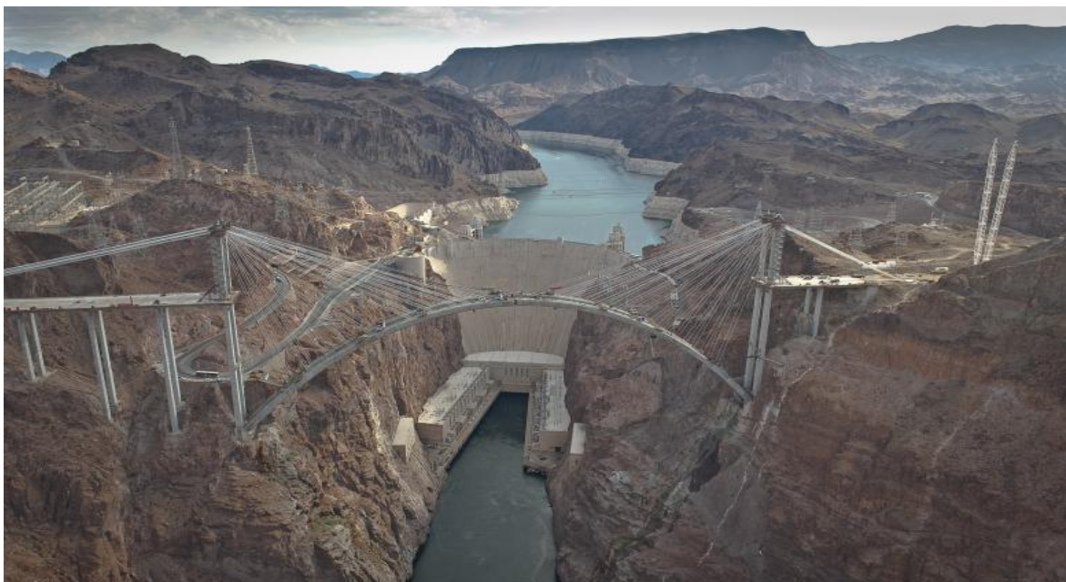
Εικόνα 5.10.1 Γέφυρα φράγματος Hoover 59
