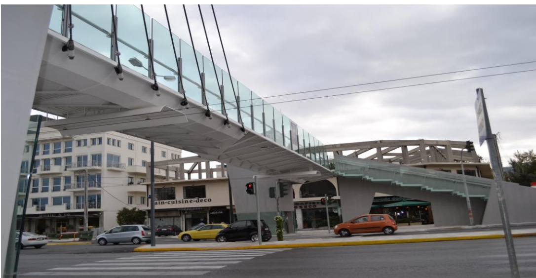
Εικόνα 6.2.3.1.4 Τελική μορφή γέφυρας. 73
