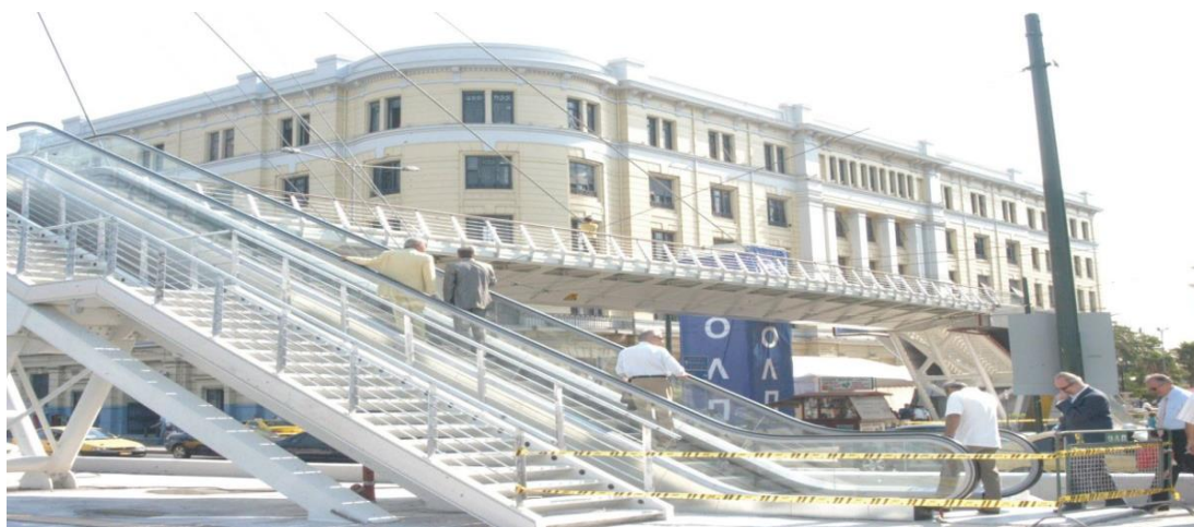
Εικόνα 6.2.2.3 Οψη κλιμακοστασίου κατά τη φάση κατασκευής 67
