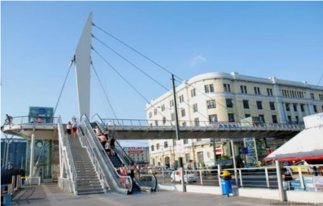
Εικόνα 6.2.2.4 Πυλώνας και καλώδια πεζογέφυρας ΟΛΠ 68
