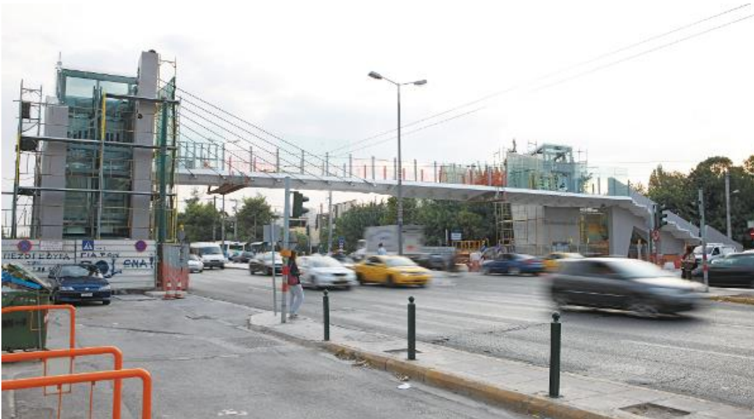
Εικόνα 6.2.3.1.3 Βόρεια όψη κατά τη φάση κατασκευής 72
