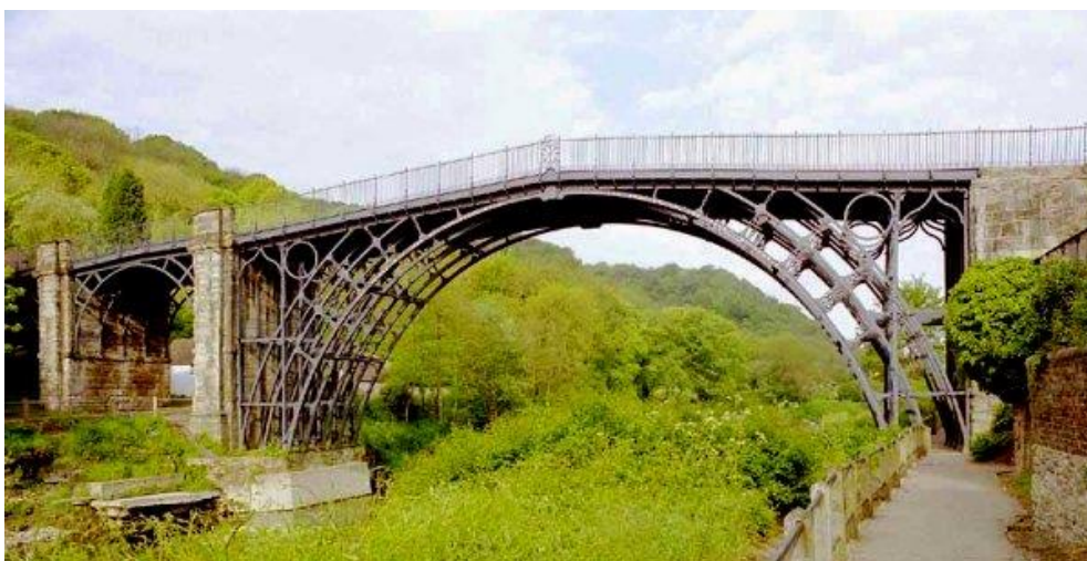
Εικόνα 1.3.5 Γέφυρα από χυτοσίδηρο στο Coalbrookdale στην Αγγλία (1779). 7
