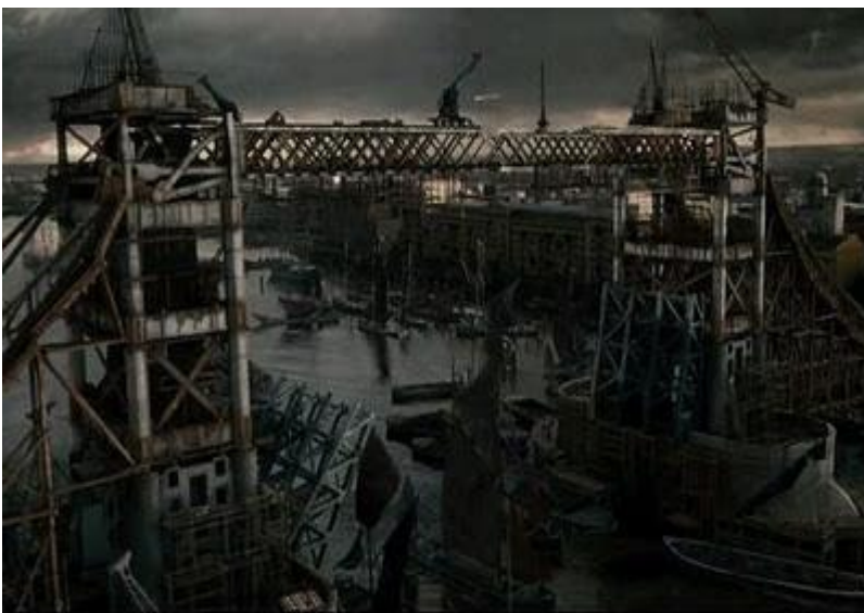
Εικόνες 5.5.1 Εργασίες κατά τη κατασκευή της γέφυρας. 47
