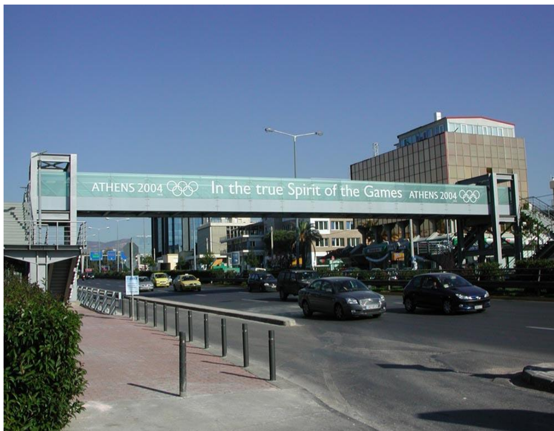
Εικόνα 6.2.3.2.1 Πεζογέφυρα στην Κηφισίας-Μαρούσι 74
