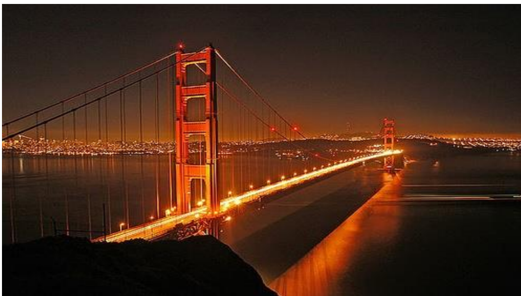
Εικόνα 5.2.3 Βραδινή λήψη της γέφυρας Golden Gate. 41
