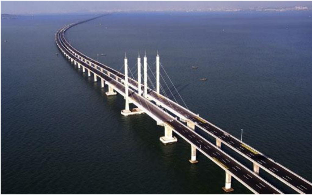
Εικόνα 5.9.2 Αεροφωτογραφία γέφυρας Qingdao Jiaozhou Bay 58
