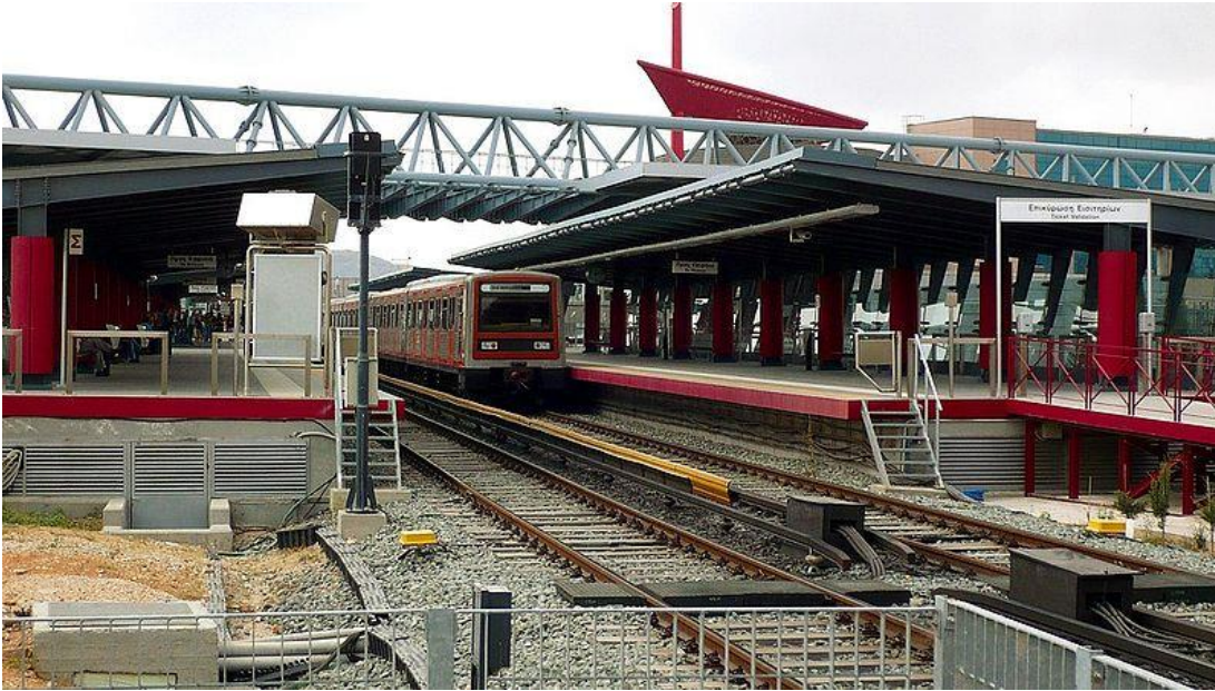
Εικόνα 6.2.4.1.1 Πεζογέφυρα πάνω από τον ΗΣΑΠ Νερατζιώτισσα 75
