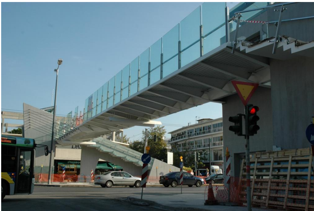
Εικόνα 6.2.3.1.2 Πεζογέφυρα κατά τη φάση κατασκευής-νότια πλευρά 71
