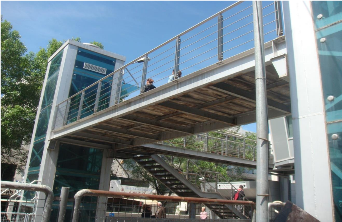
Εικόνα 6.2.4.3.2 Όψη της γέφυρας από το επίπεδο του σταθμού 79
