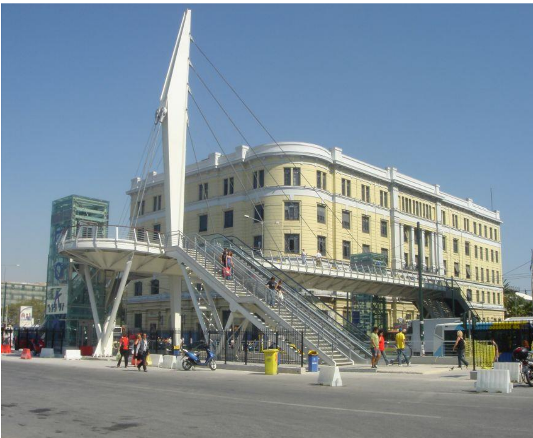
Εικόνα 6.2.2.5 Γενική όψη της γέφυρας ΟΛΠ 69
