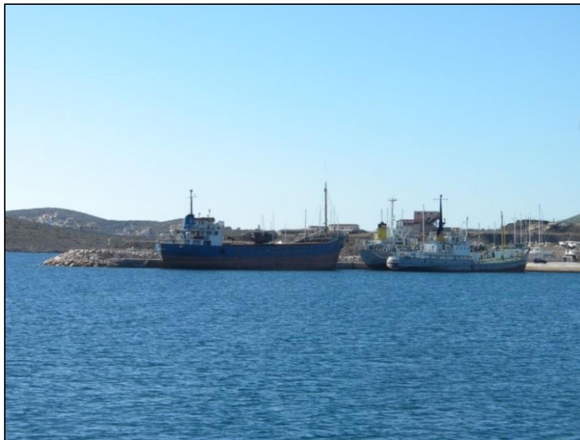
Εικόνα 3.2: Άποψη του υπήνεμου μόλου
