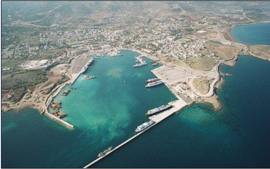
Εικόνα 2.1: Γενική άποψη του λιμένα του Λαυρίου ( www.lavriaki.gr )
