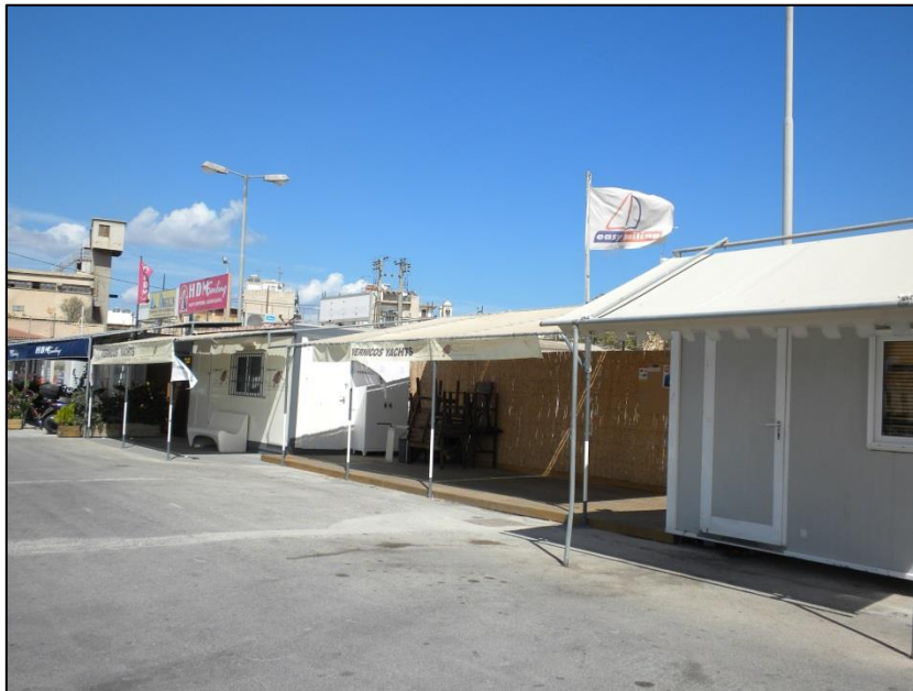
Εικόνα 3.19: Προσωρινές κατασκευές επί του Προβλήτα II
