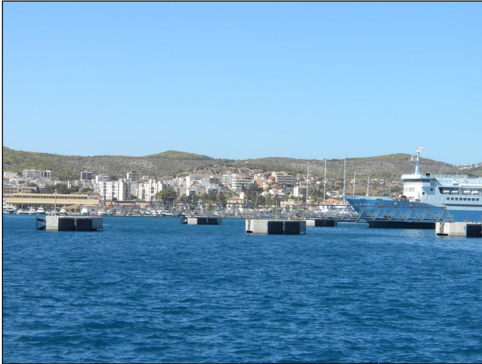
Εικόνα 3.6: Συστοιχίες σταθερών μονοναυδέτων (finger piers)
