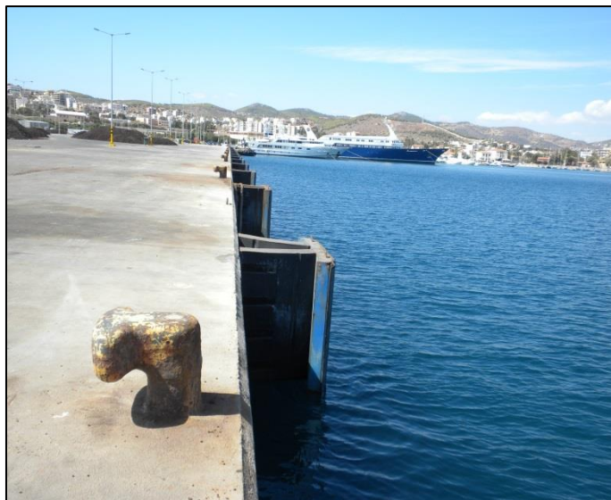
Εικόνα 3.8: Δάπεδα νοτίων κρηπιδωμάτων
