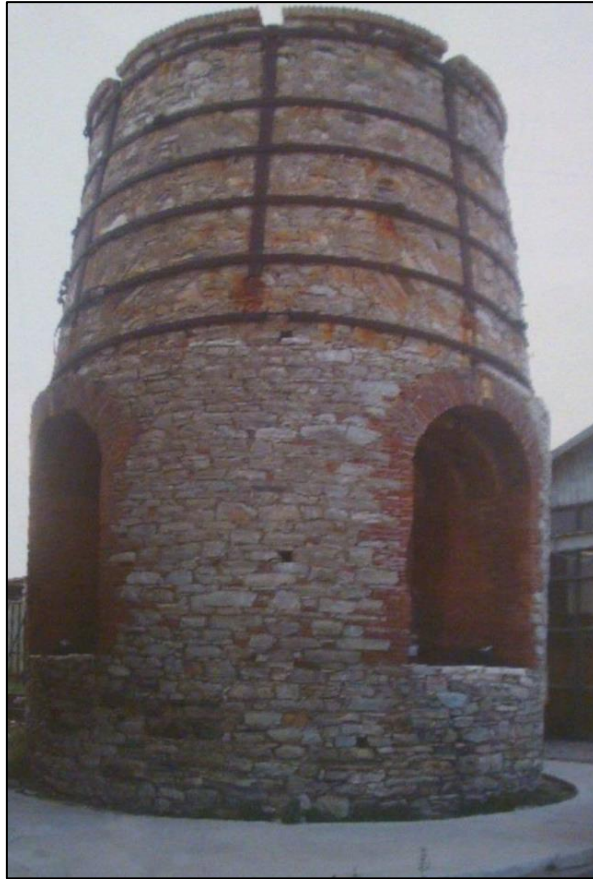
Εικόνα 2.10: Κάμινος πύρωσης καλαμίνας της Ελληνικής Εταιρείας Μεταλλείων Λαυρίου ( www.lavrioguide.gr )
