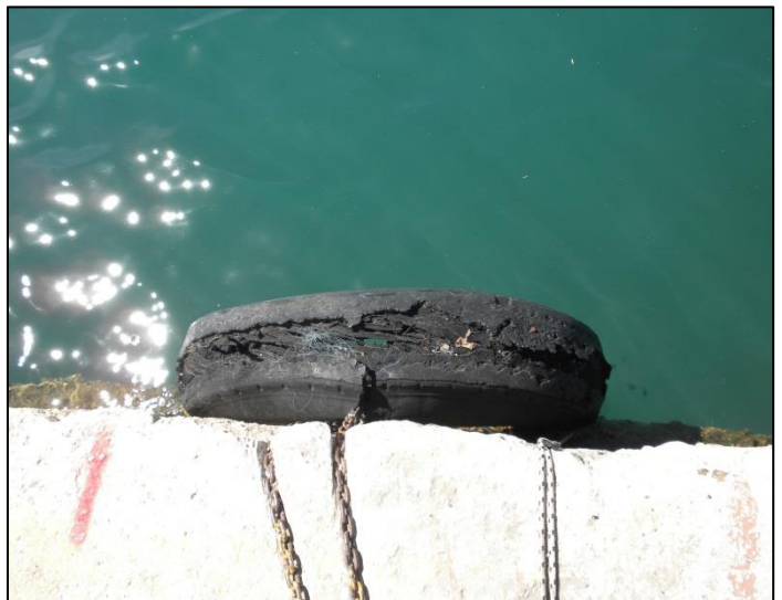
Εικόνα 5.5: Φθαρμένοι προσκρουστήρες
