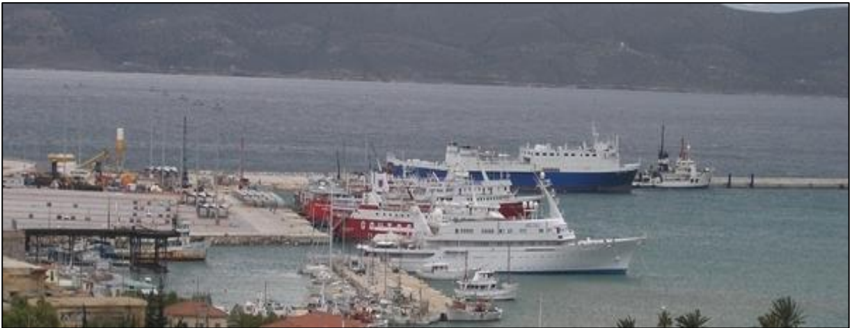
Εικόνα 3.3: Γενική άποψη κρηπιδωμάτων Λιμενικού Τμήματος Ακτοπλοΐας (Ο.Α.Α.)
