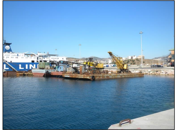
Εικόνα 3.5: Κατάληψη του τμήματος χωρίς κρηπίδωση από φορτηγίδες
