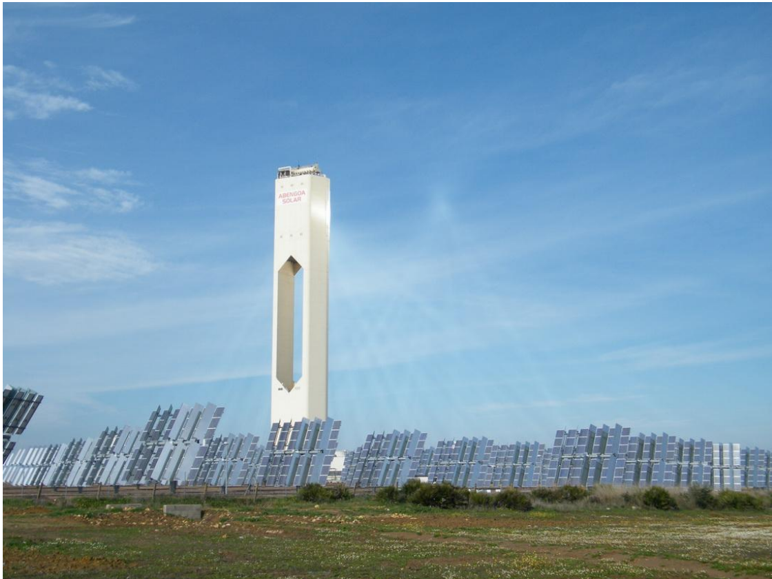
Σχήμα1. 6: Εγκατάσταση Ηλιακού Πύργου PS10 (7)
