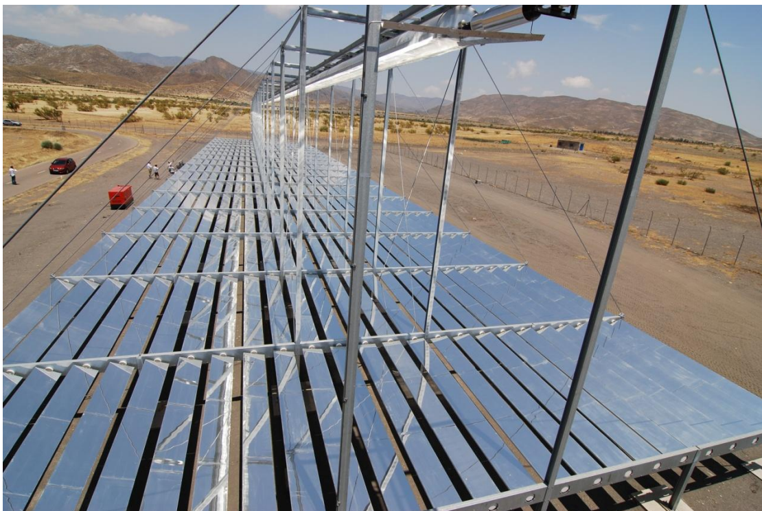
Σχήμα1. 8: Τυπική Εγκατάσταση συστήματος ανακλαστήρων Fresnel
