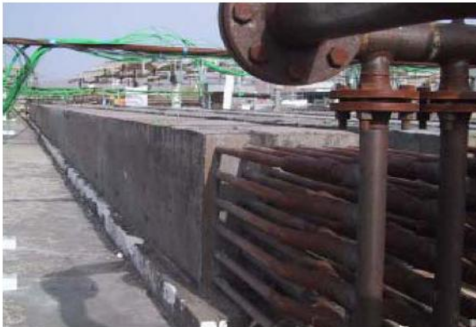
Σχήμα 2. 13: Τυπικό παθητικό σύστημα αποθήκευσης με χρήση σκυροδέματος
