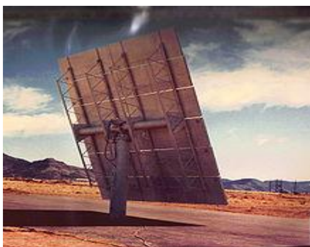
Σχήμα 3. 5: Τυπικό σχήμα βάσης Στήριξης Ηλιοστάτη
