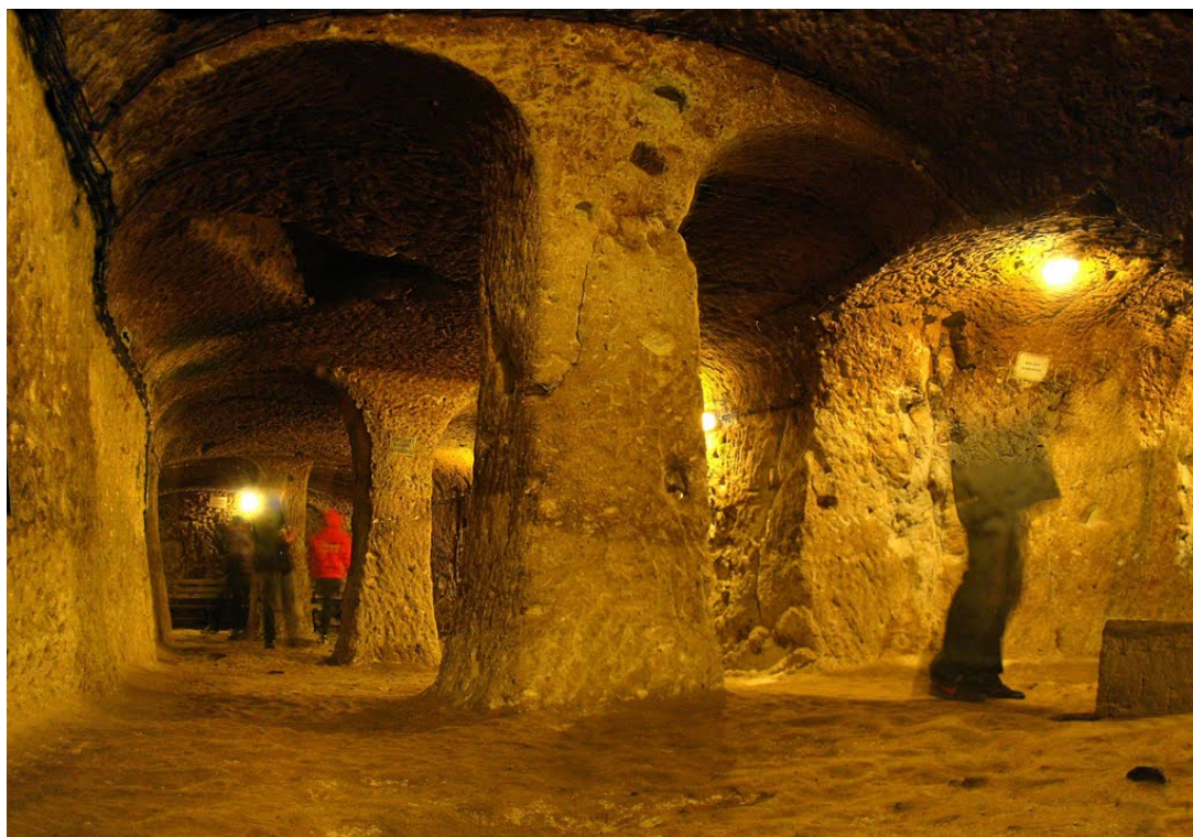
Εικόνα 21. Πυλώνες – υποστυλώματα στήριξης των υπερκείμενων ορόφων στον υπόγειο οικισμό του Derinkuyu.
