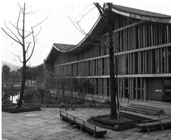
εικ.62 : Νότια πλευρά της σχολής αρχιτεκτονών
