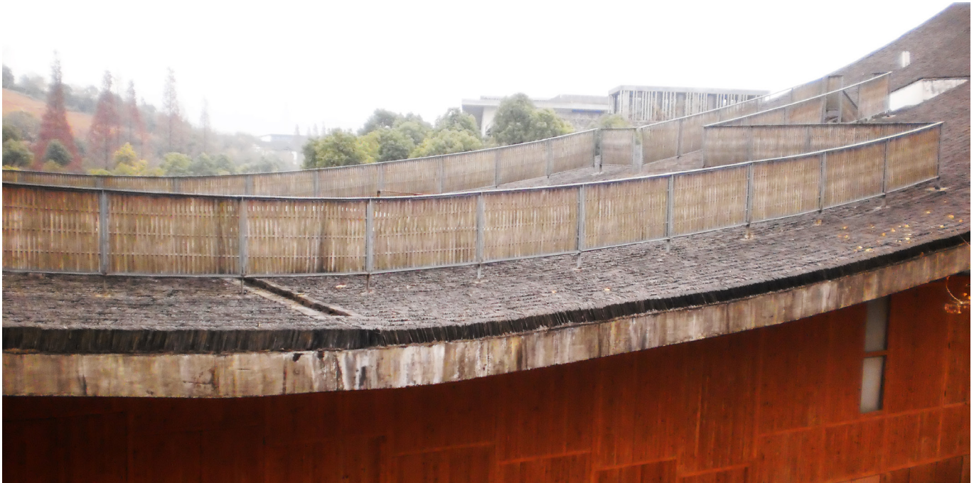
εικ.61 : Λεπτομέρεια στέγης
