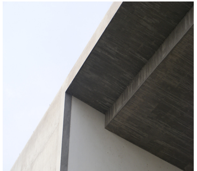
εικ.84 : Λεπτομέρεια της στέγης
