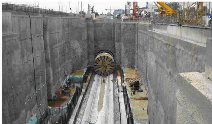
Εικόνα 2.11 Το TBM στο Ελληνικό(Πηγή: Αττικό Μετρό Α.Ε.)
