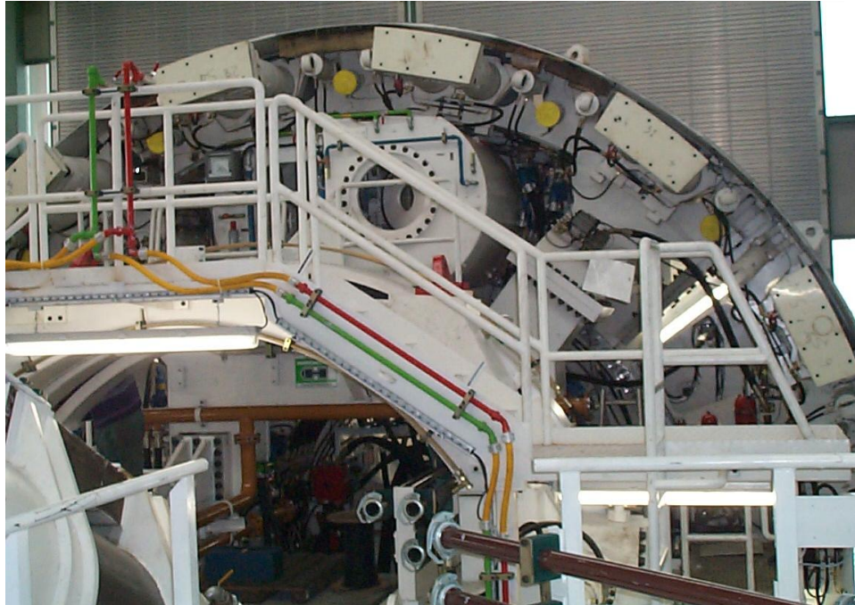
Εικόνα 2.8 Θάλαμος αποσυμπίεσης και κύλινδροι προώθησης (Πηγή: Αττικό Μετρό Α.Ε.)
