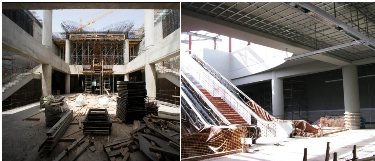
Εικόνα 2.5 Εσωτερικό σταθμών κατά την κατασκευή (Πηγή: http://www.ametro.gr )
