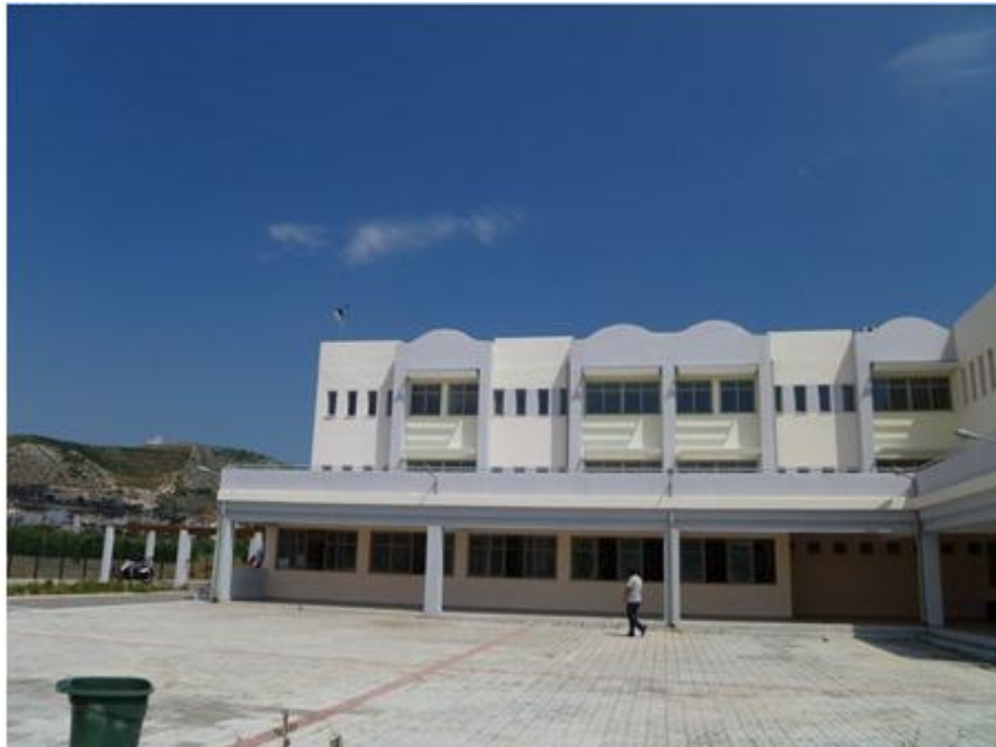
Εικόνα 4.11: Ο μετεωρολογικός σταθμός στα Άνω Λιόσια
