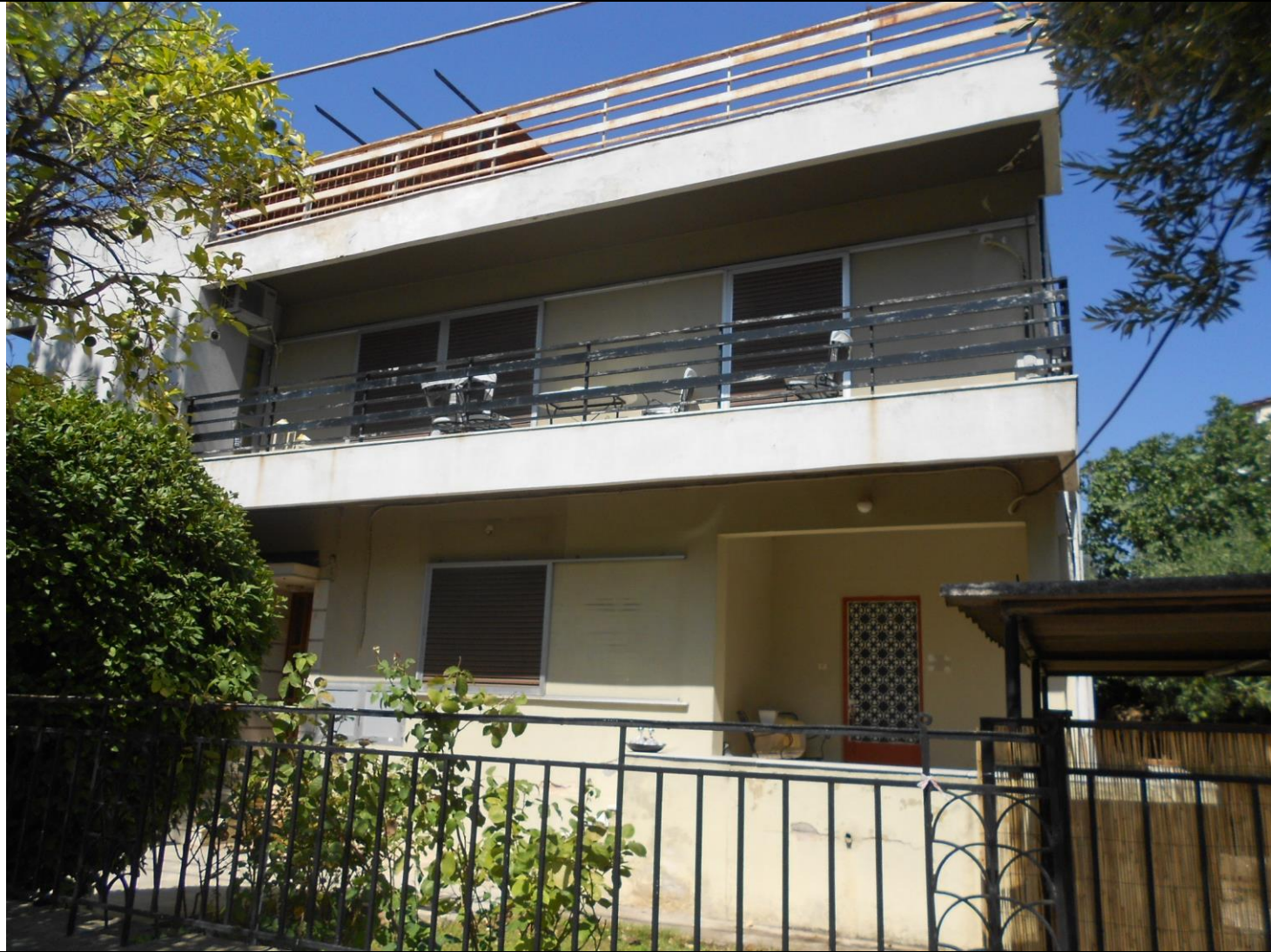
Εργοτάξιο 1. Περιοχή: Χαλάνδρι Φωτογραφία οικοπέδου (κτίριο προς κατεδάφιση)
