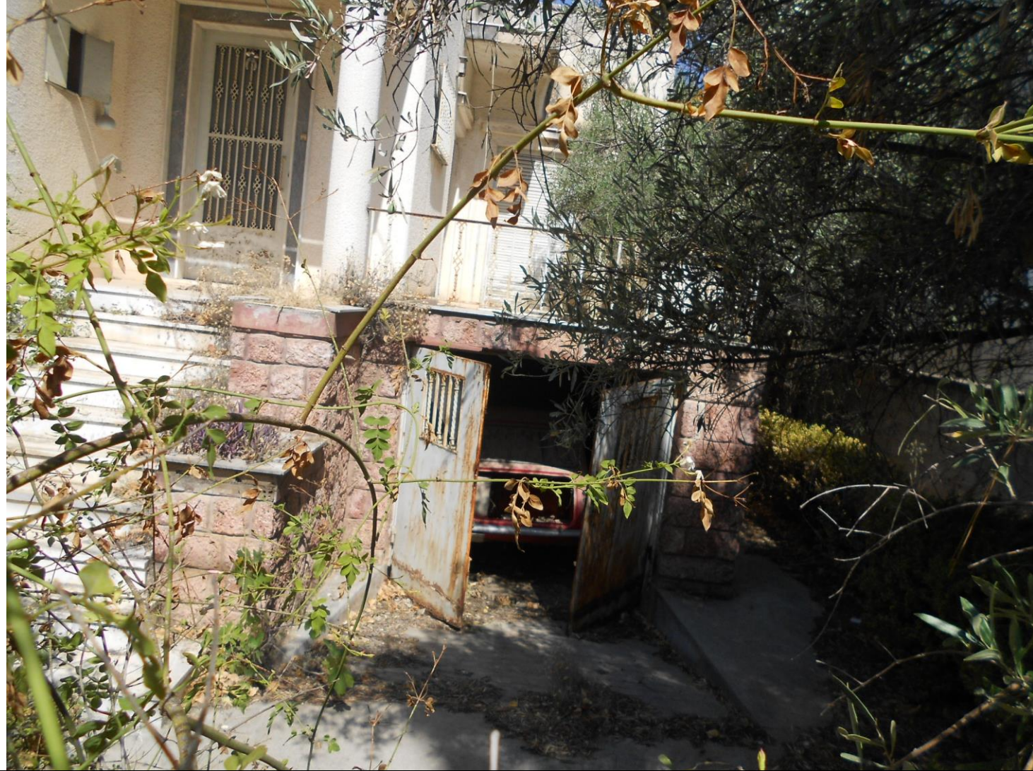
Εργοτάξιο 10. Περιοχή: Μελίσσια Φωτογραφία οικοπέδου (κτίριο προς κατεδάφιση)
