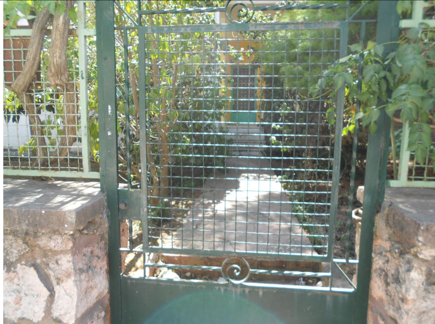
Εργοτάξιο 6. Περιοχή: Χαλάνδρι Φωτογραφία οικοπέδου (κτίριο προς κατεδάφιση)
