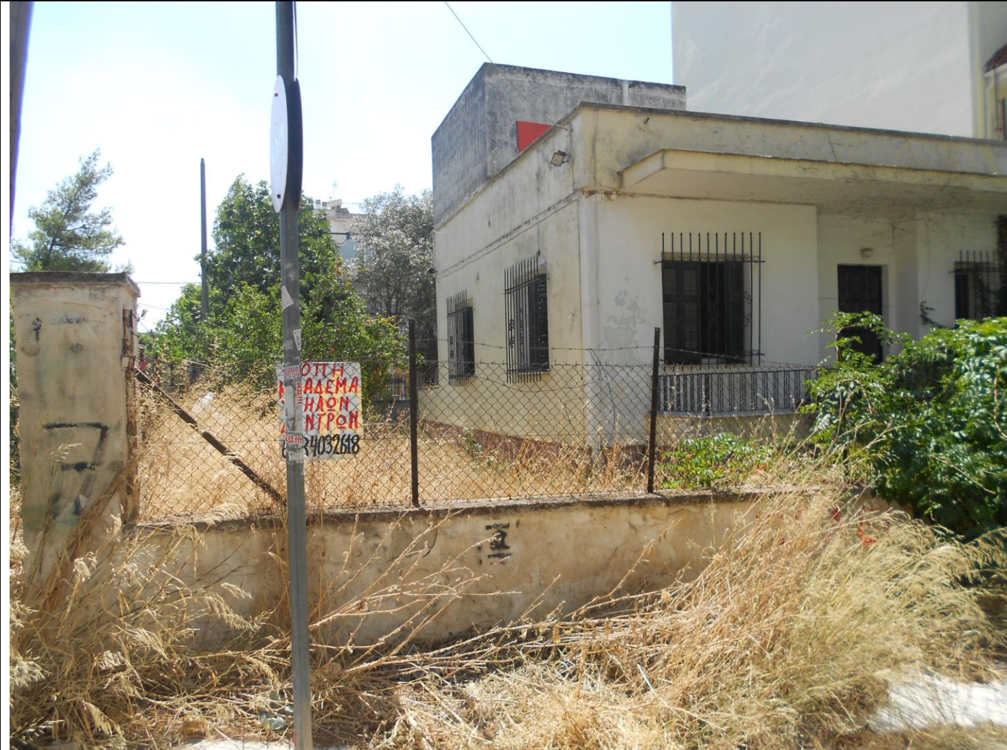
Εργοτάξιο 13. Περιοχή: Μελίσσια Φωτογραφία οικοπέδου (κτίριο προς κατεδάφιση)
