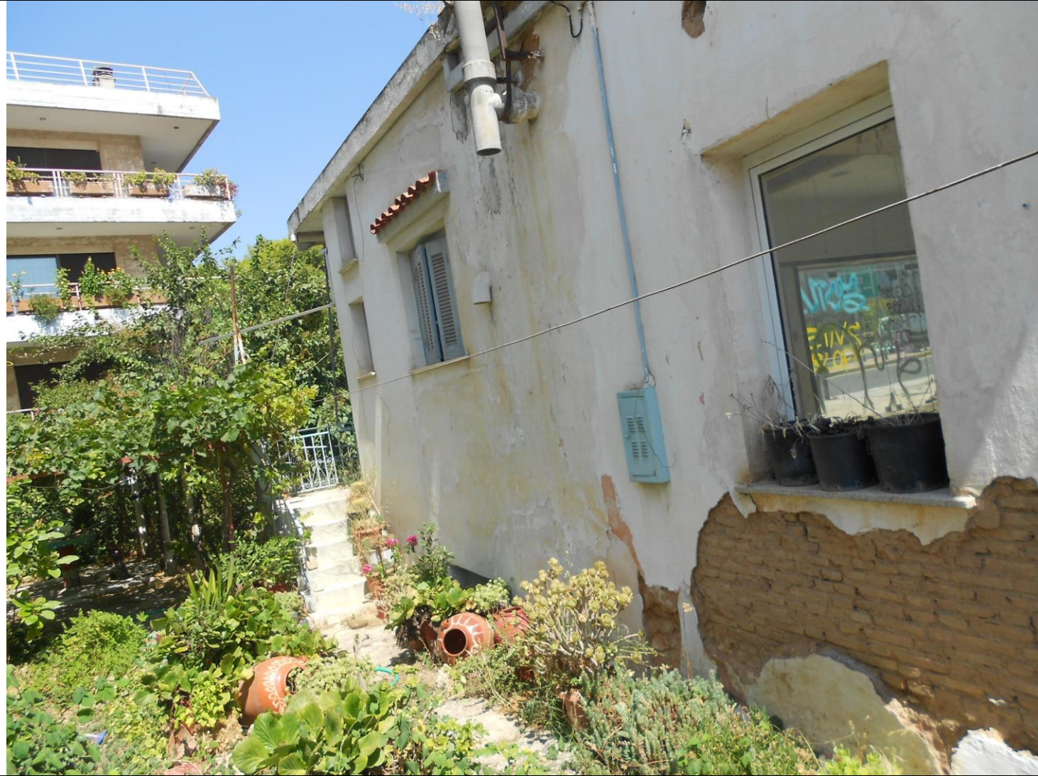
Εργοτάξιο 16. Περιοχή: Γέρακας Φωτογραφία οικοπέδου (κτίριο προς κατεδάφιση)
