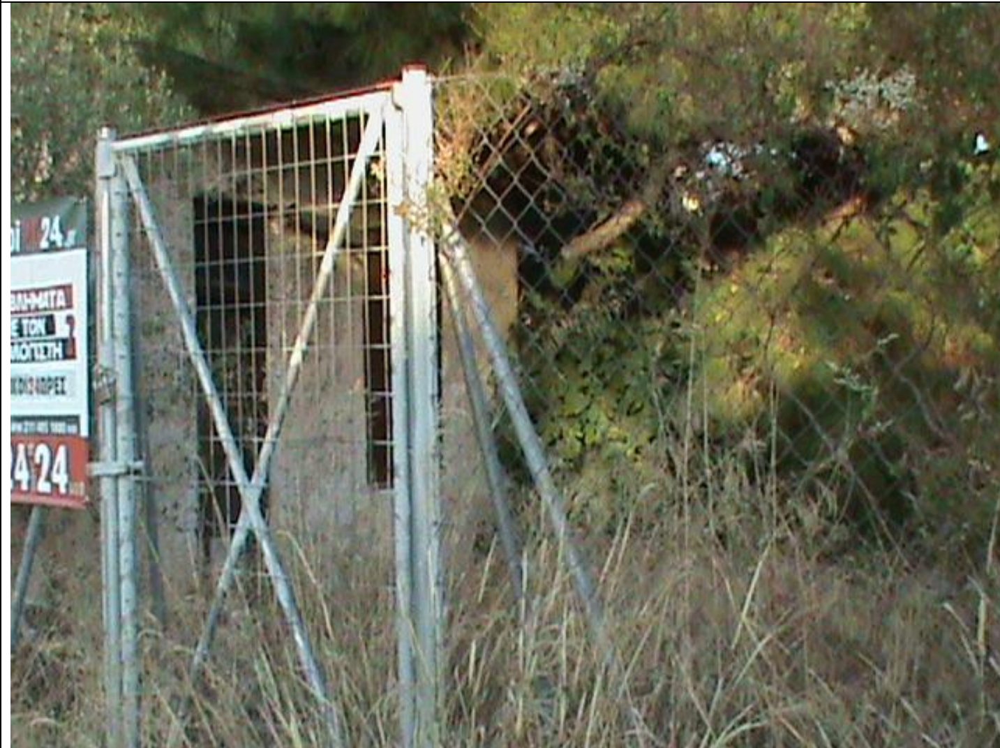
Εργοτάξιο 28. Περιοχή: Βριλήσσια Φωτογραφία οικοπέδου (κτίριο προς κατεδάφιση)
