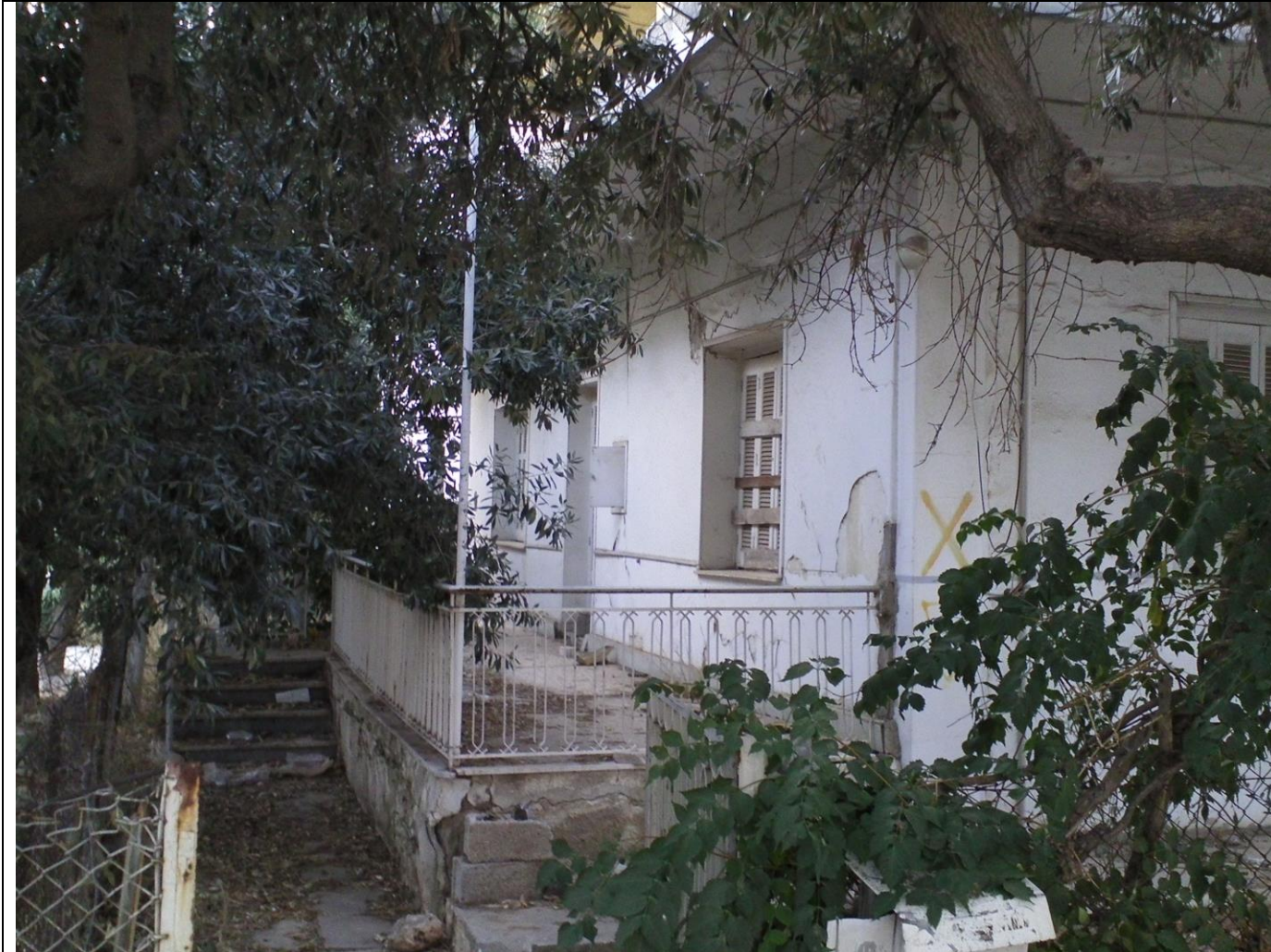
Εργοτάξιο 2. Περιοχή: Αγία Παρασκευή Φωτογραφία οικοπέδου (κτίριο προς κατεδάφιση)
