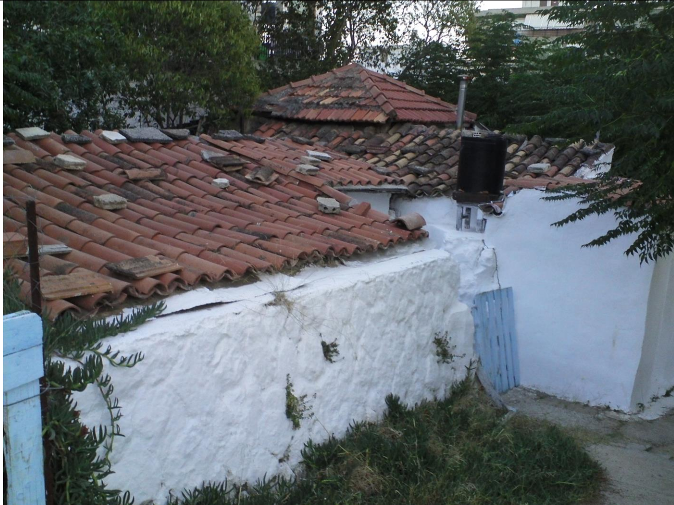
Εργοτάξιο 18. Περιοχή: Βριλήσσια Φωτογραφία οικοπέδου (κτίριο προς κατεδάφιση)
