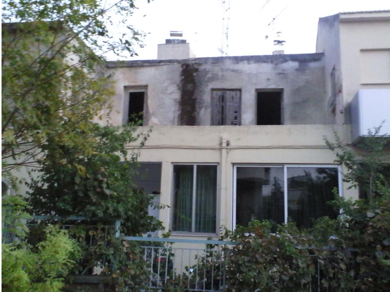
Εργοτάξιο 8. Περιοχή: Παλλήνη Φωτογραφία οικοπέδου (κτίριο προς κατεδάφιση)
