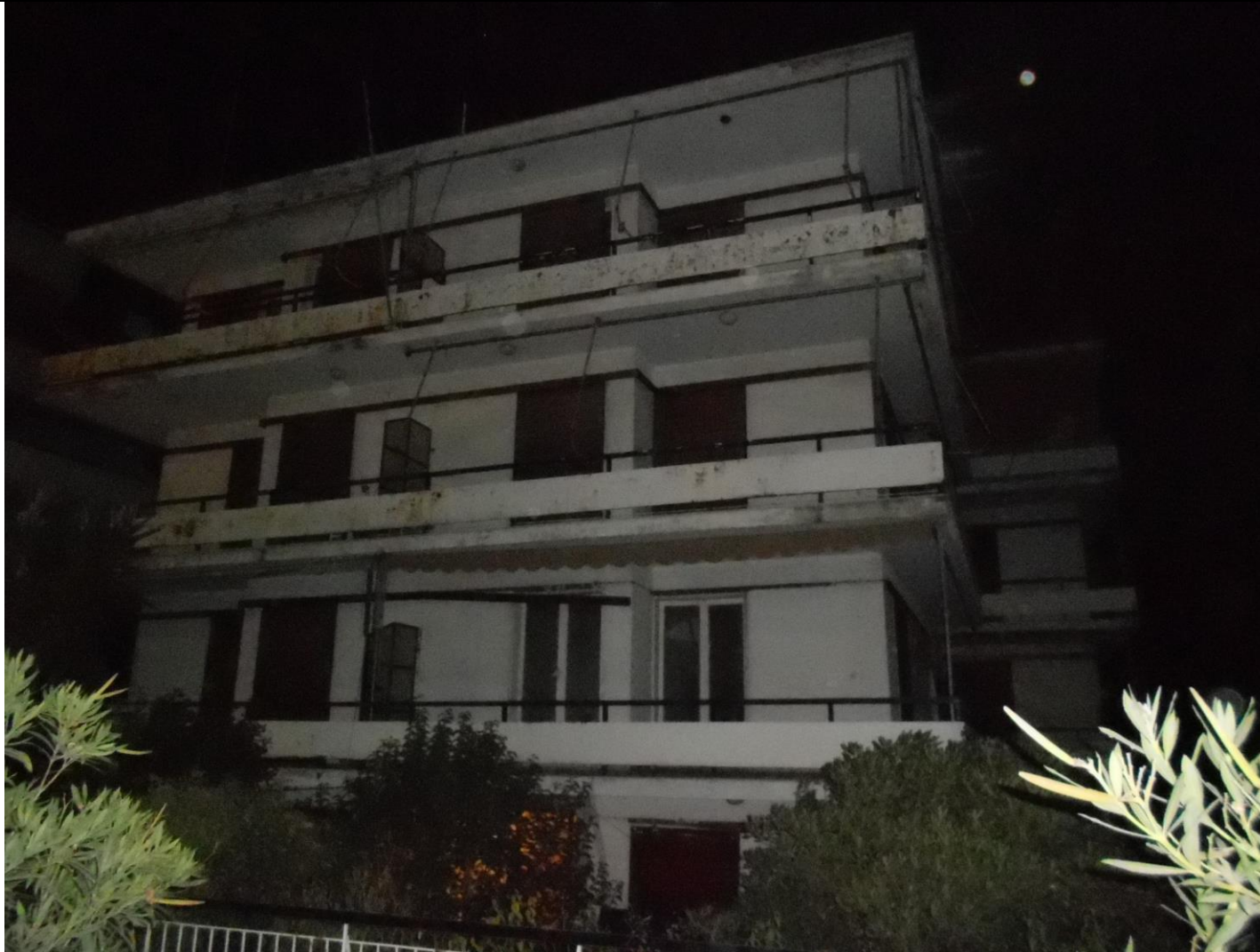
Εργοτάξιο 17. Περιοχή: Βριλήσσια Φωτογραφία οικοπέδου (κτίριο προς κατεδάφιση)
