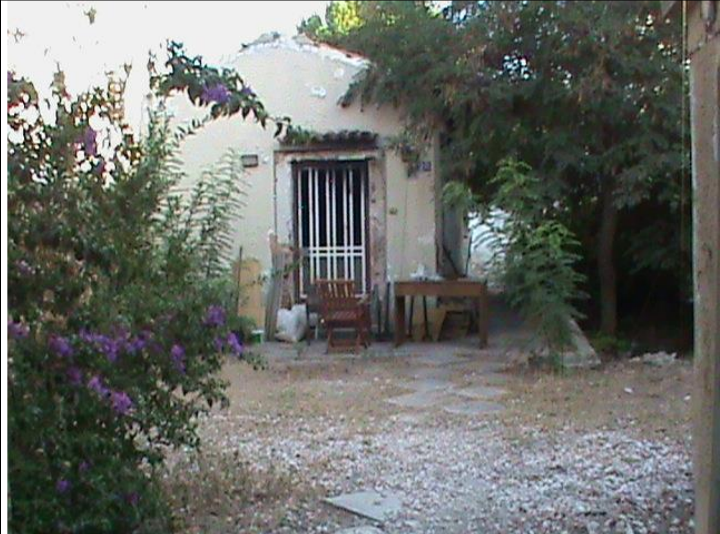
Εργοτάξιο 19. Περιοχή: Χολαργός Φωτογραφία οικοπέδου (κτίριο προς κατεδάφιση)
