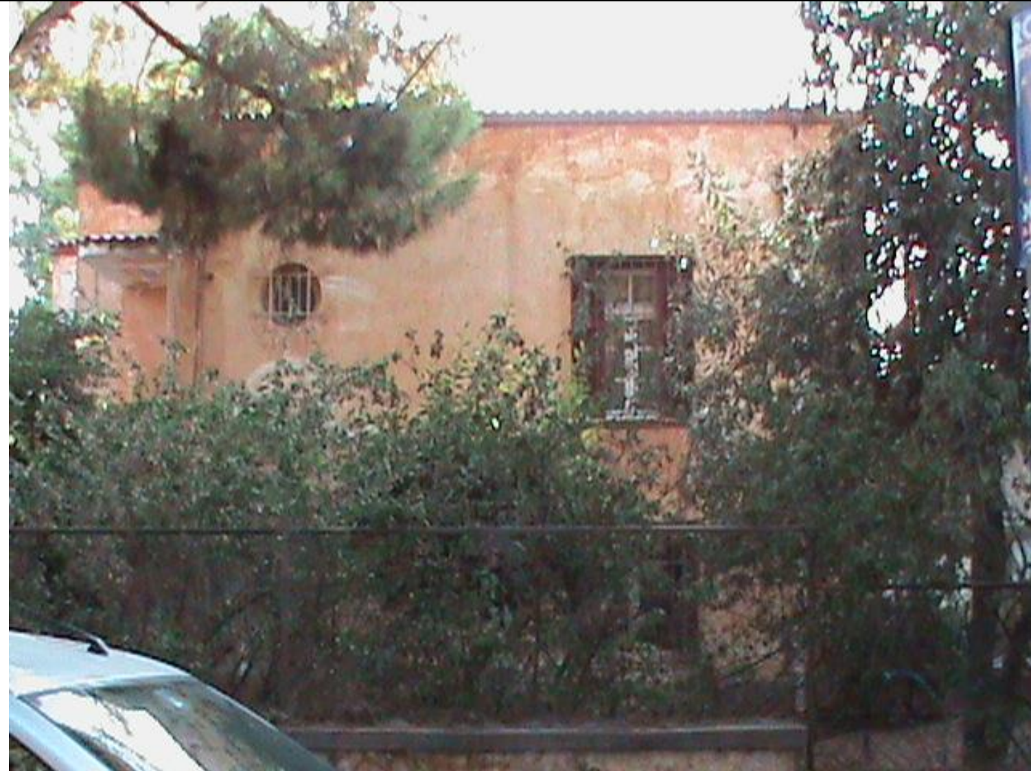
Εργοτάξιο 24. Περιοχή: Αγία Παρασκευή Φωτογραφία οικοπέδου (κτίριο προς κατεδάφιση)
