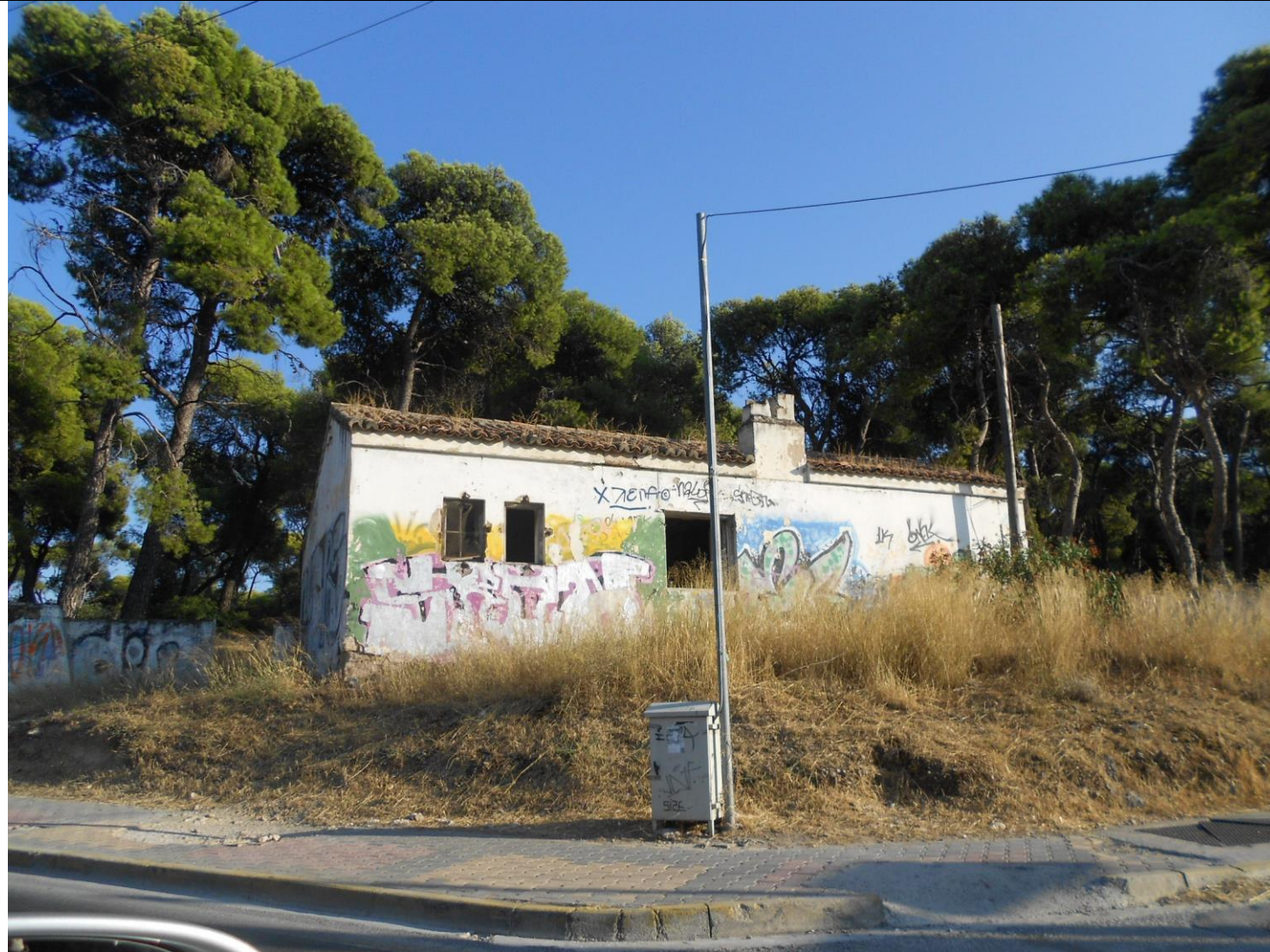
Εργοτάξιο 7. Περιοχή: Αγία Παρασκευή Φωτογραφία οικοπέδου (κτίριο προς κατεδάφιση)
