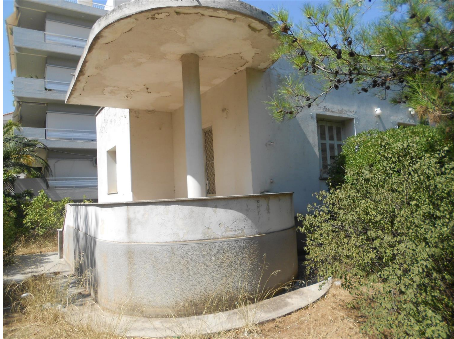
Εργοτάξιο 12. Περιοχή: Χολαργός Φωτογραφία οικοπέδου (κτίριο προς κατεδάφιση)
