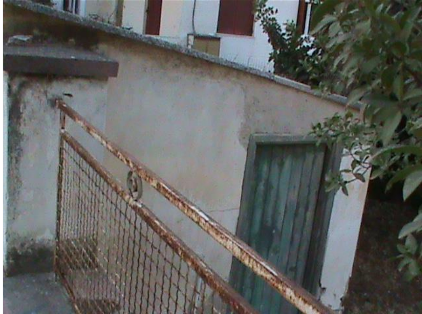
Εργοτάξιο 23. Περιοχή: Χολαργός Φωτογραφία οικοπέδου (κτίριο προς κατεδάφιση)
