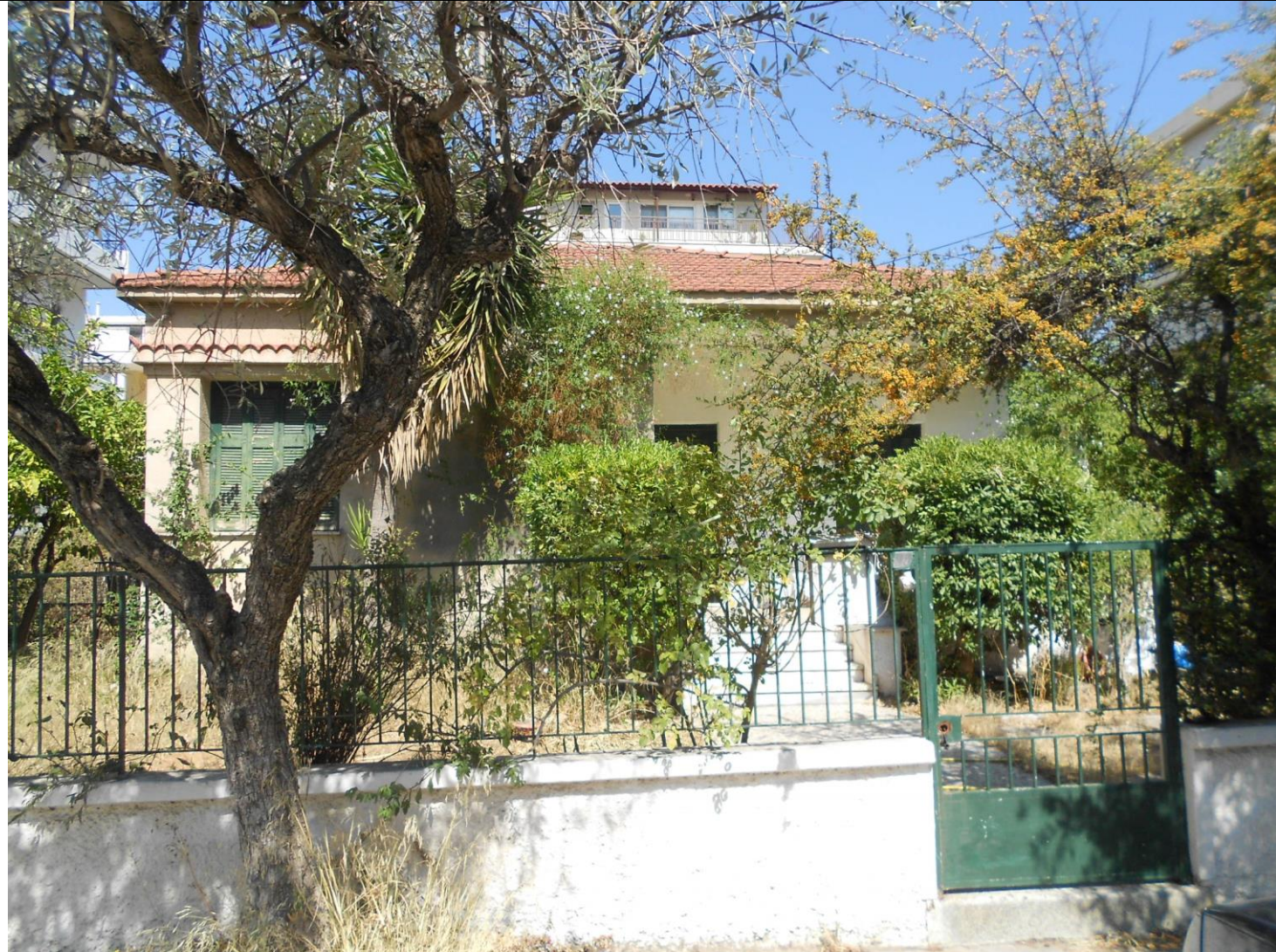
Εργοτάξιο 11. Περιοχή: Βριλήσσια Φωτογραφία οικοπέδου (κτίριο προς κατεδάφιση)
