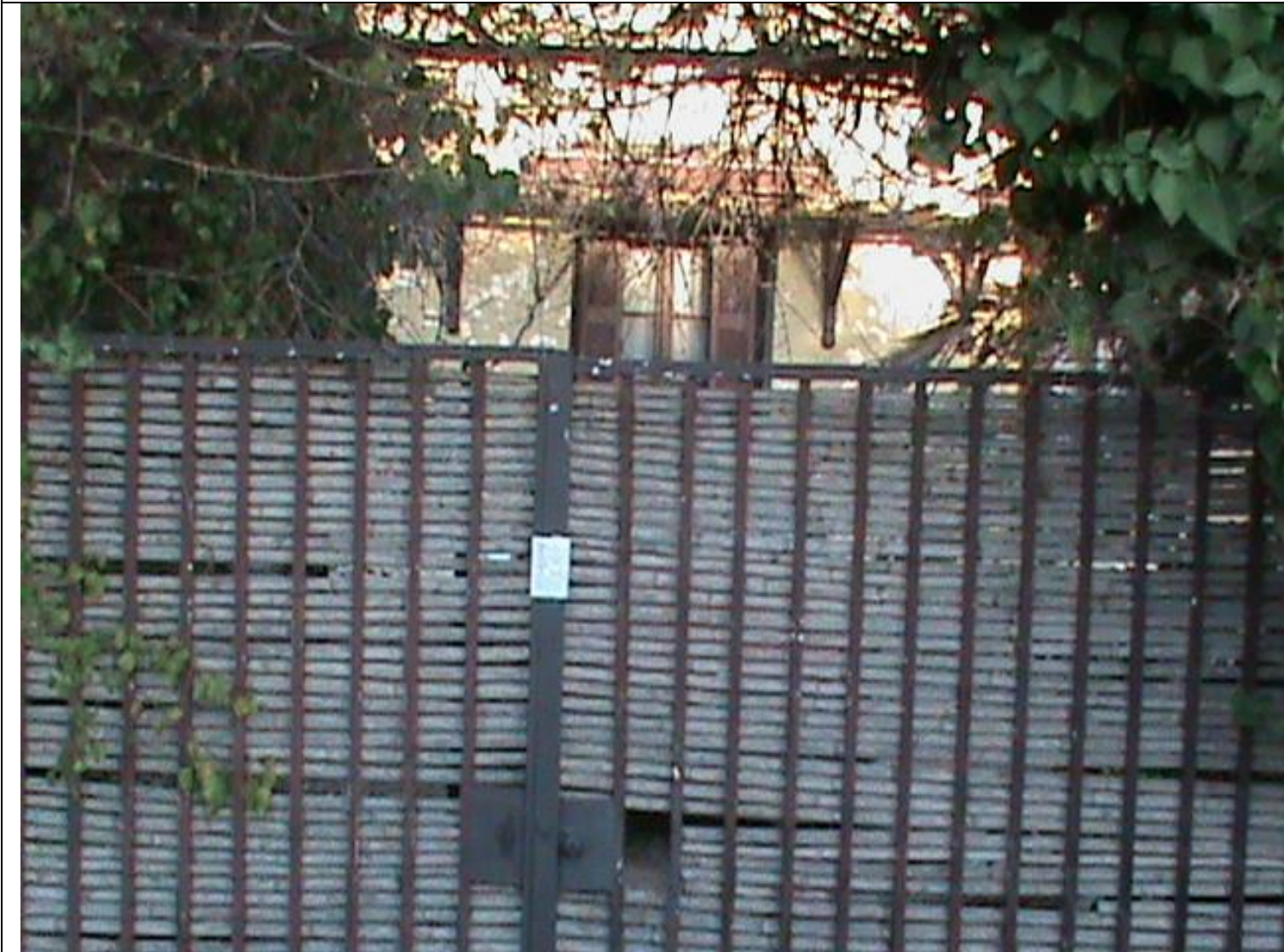
Εργοτάξιο 30. Περιοχή: Αγία Παρασκευή Φωτογραφία οικοπέδου (κτίριο προς κατεδάφιση)
