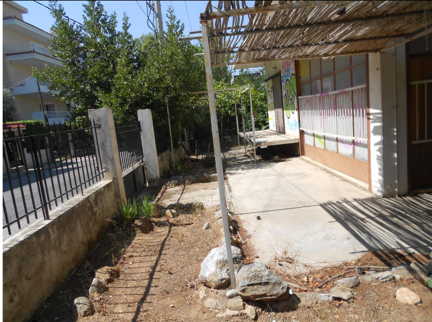
Εργοτάξιο 14. Περιοχή: Αγία Παρασκευή Φωτογραφία οικοπέδου (κτίριο προς κατεδάφιση)
