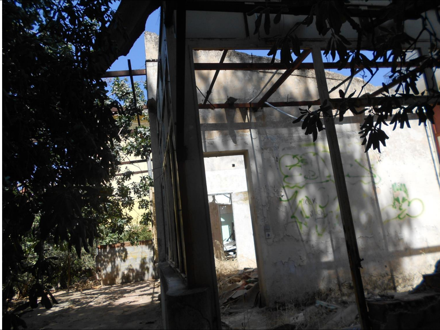
Εργοτάξιο 26. Περιοχή: Χολαργός Φωτογραφία οικοπέδου (κτίριο προς κατεδάφιση)
