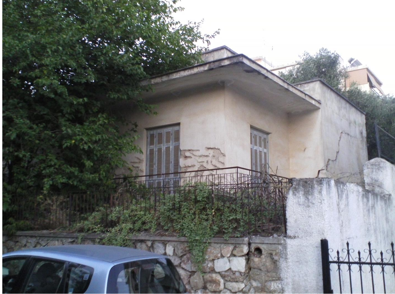
Εργοτάξιο 5. Περιοχή: Μελίσσια Φωτογραφία οικοπέδου (κτίριο προς κατεδάφιση)
