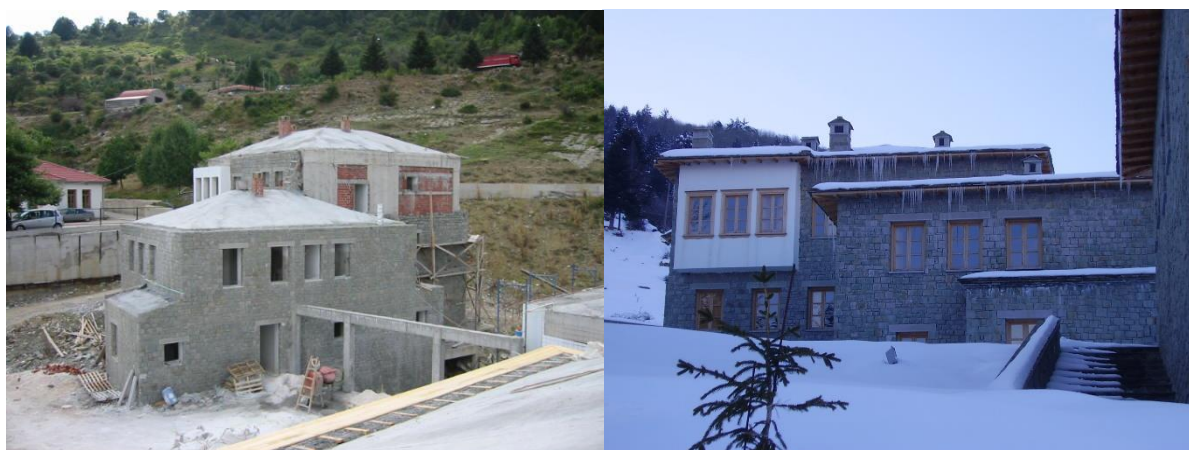
Εικόνα 20: Το Μετσόβιο Κέντρο Διεπιστημονικής Έρευνας, σε φάσεις κατασκευής και λειτουργίας
