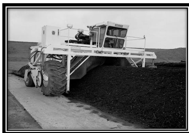
Εικόνα 1.3-9. Μηχανή τοποθέτησης κόμποστ σε σωρούς (Dubois, González, 2004)
