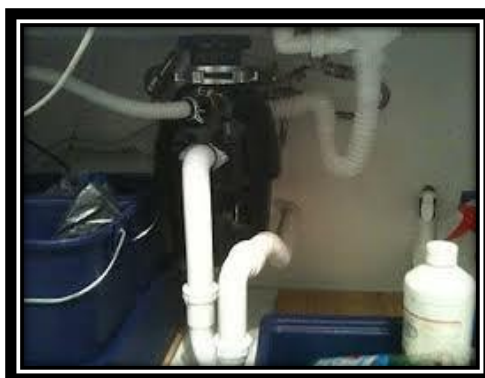
Εικόνα 1.2-5. Σκουπιδοφάγος τοποθετημένος κάτω από τον νεροχύτη οικίας (Alina, 2012)
