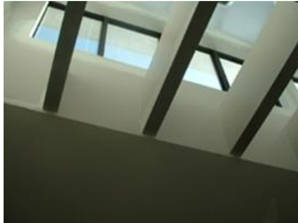
Σχήμα 5.3: Ανοίγματα στην οροφή για την εξασφάλιση φυσικού φωτισμού και αερισμού (Πηγή: http://www.evonymos.org )
