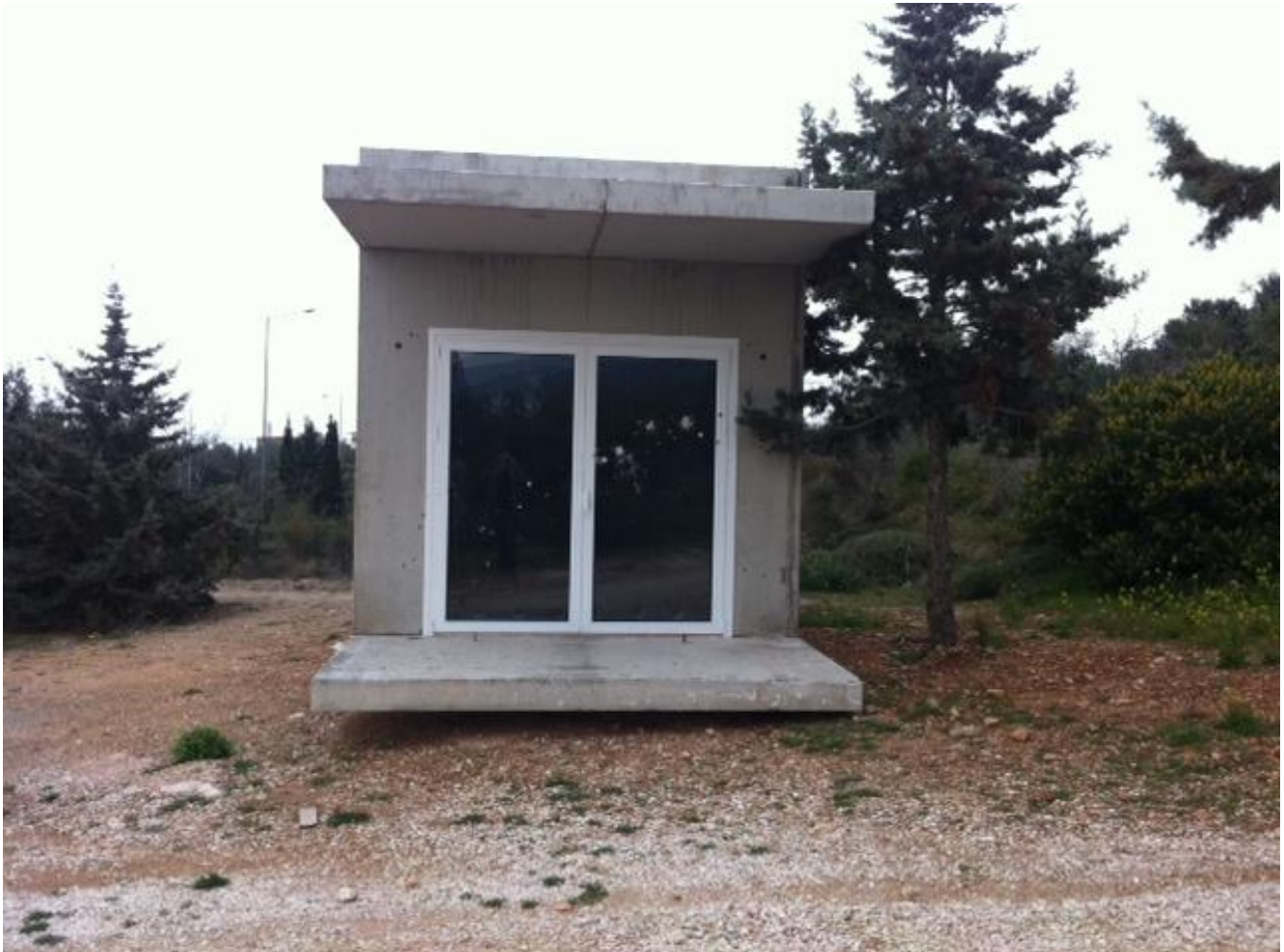
Σχήμα 10.10: Φωτογραφία προκατασκευασμένου κτιρίου με τοίχο Trombe
