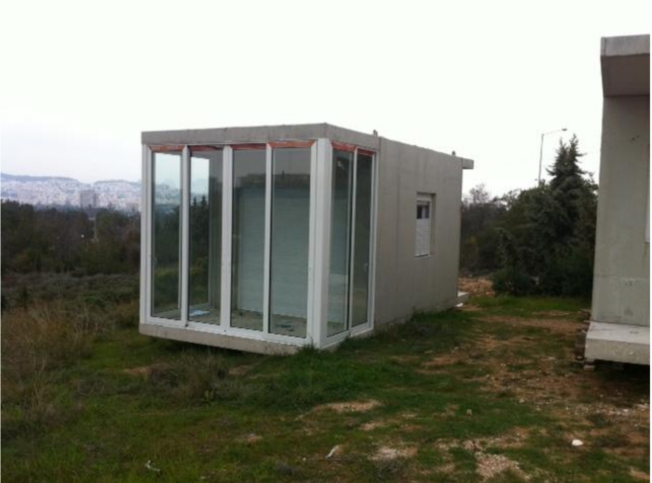
Σχήμα 10.14: Φωτογραφία προκατασκευασμένου κτιρίου με θερμοκήπιο
