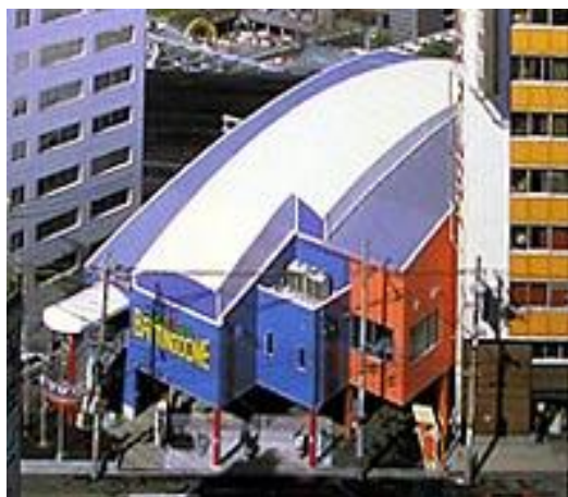
Εικόνα 8.4 Εφαρμογή υπερυδρόφιλων επικαλύψεων σε στέγη σιδηροδρομικού σταθμού στην Ιαπωνία (Taiyo Kogyo Corporation) [2].
