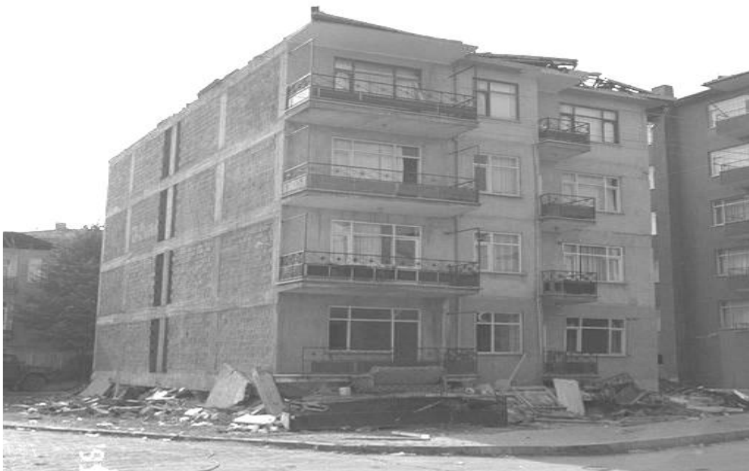
Σχ. 1.7: Απώλεια ορόφου μετά από τον σχηματισμό πλαστικού ορόφου
