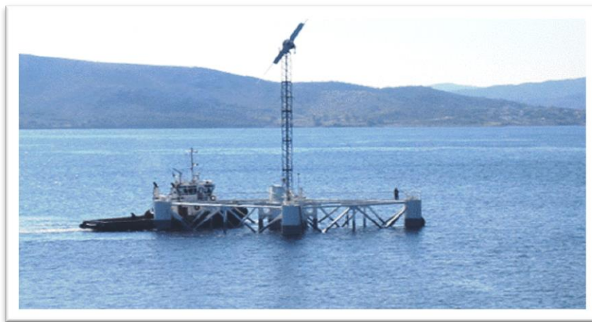
Εικόνα 1.2.5.2: Η «Υδριάδα», η πρώτη παγκοσμίως πλωτή μονάδα αφαλάτωσης (Πηγή : www.ecofinder.gr )
