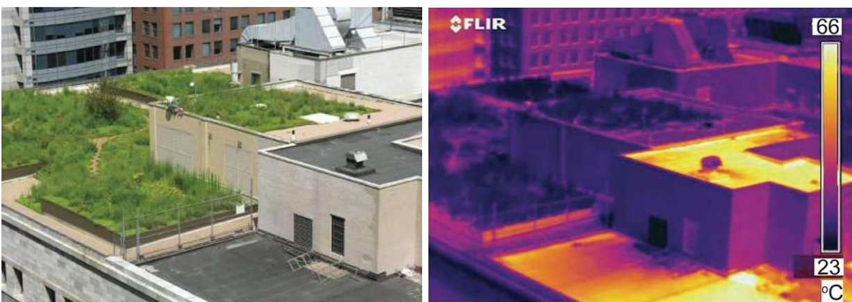
Εικ.1.2 :Φωτογραφία και θερμοφωτογραφία κατά την περίοδο μιας τυπικής ημέρας, του δώματος του δημαρχείου του Chicago όπου φαίνεται η πράσινη στέγη έχει κατά 40° C χαμηλότερη θερμοκρασία από το γειτονικό συμβατικό δώμα. [Πηγή: www.anelixi.org ]
