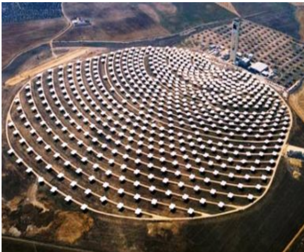
Σχήμα 3.5 Συγκεντρωτικό ηλιακό σύστημα
