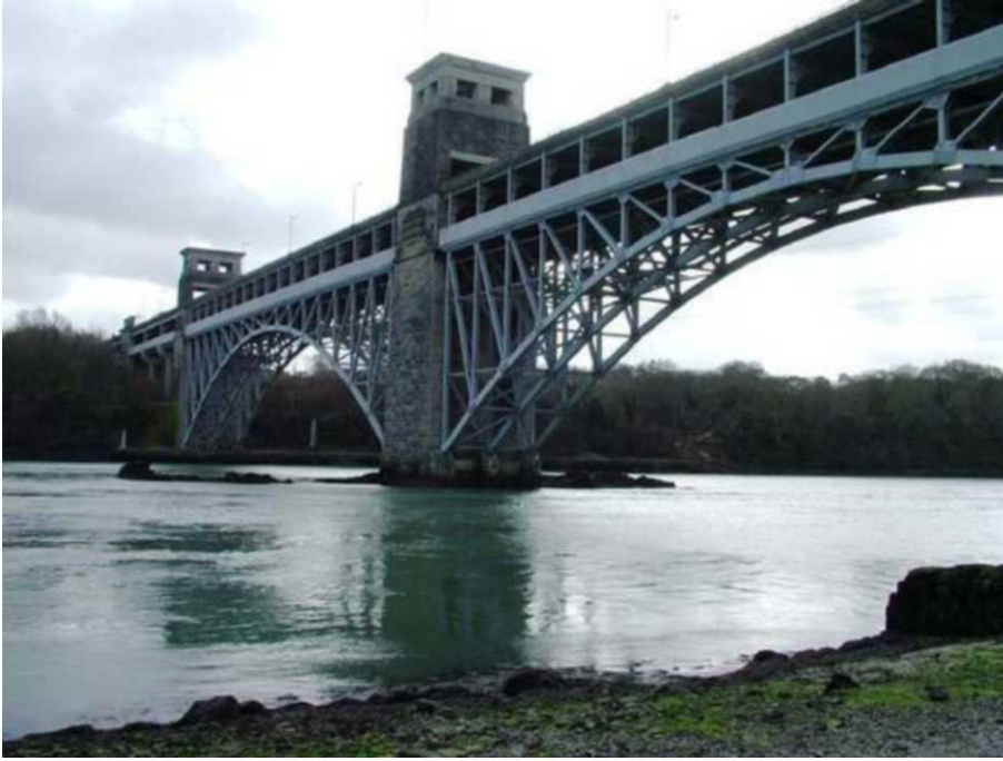
Εικ. 1.2: Britannia Bridge
