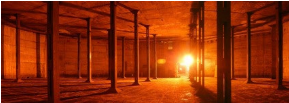
(Εικόνα 13) Εσωτερικό μιας δεξαμενής πετρελαίου.
