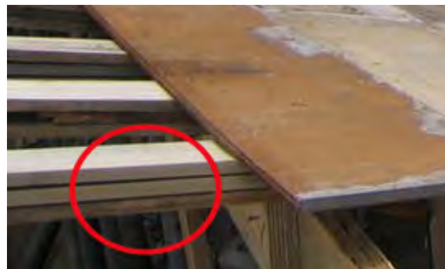
Εικόνα 42. Λεπτομέρεια των εγκάρσιων νευρώσεων του ξυλότυπου οροφής από τρεις τάβλες καθ' ύψος
