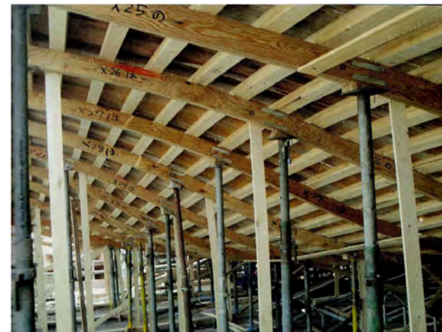
Εικόνα 41. Άποψη του ολοκληρωμένου ξυλότυπου οροφής από την κάτω στάθμη του
