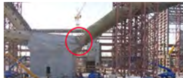
Εικόνα 64. Ο κόμβος των αντεστραμμένων δενδροειδών εκλυστήρων στο δάπεδο
