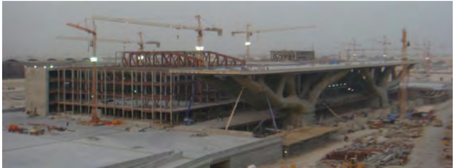
Εικόνα 116. Νωπό σκυρόδεμα στην πλάκα του υπόστεγου λίγη ώρα μετά τη σκυροδέτηση. Φωτογραφία από το εργοτάξιο
