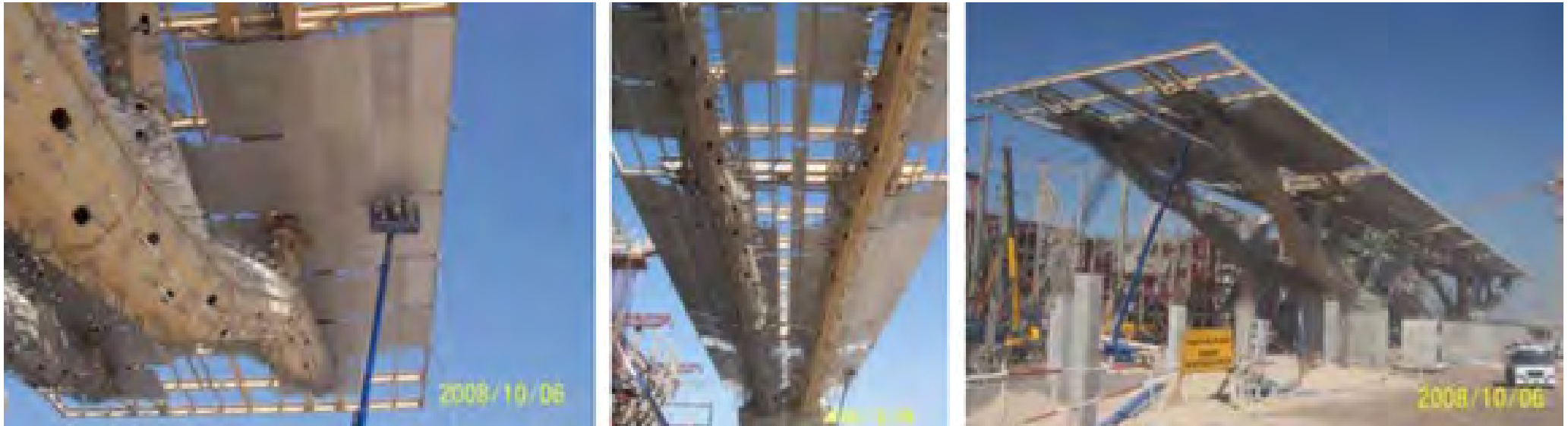
Εικόνες 117,118 & 119. Λεπτομέρειες του μεταλλότυπου και του οπλισμού της πλάκας του υπόστεγου. Όλος ο υπόστεγος όγκος υποδοχής του κτιρίου κατασκευάστηκε πριν από τον κύριο όγκο του κτιρίου.
