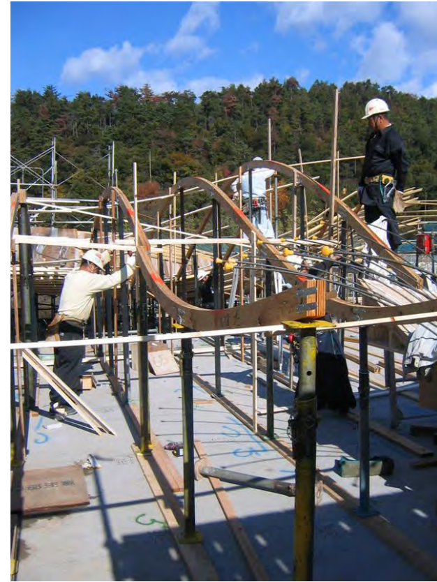
Εικόνα 40. Στιγμιότυπο της ανέγερσης του ξυλότυπου οροφής στο εργοτάξιο
