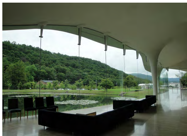
Εικόνα 20. Άποψη από το εσωτερικό. Το κάσμα των υαλοστασίων ακολουθεί την παραμετρική μορφή της στέγης στην άνω απόληξή του.
