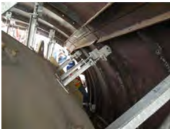
Εικόνα 100. Ολοκληρωμένο τμήμα κλαδιού. Διακρίνονται η μεταλλική επιφάνεια του οκταγώνου, οι ρυθμιζόμενοι αποστάτες τα καμπλωμένα τεμάχια λαμαρίνας και οι εγκάρσιες νευρώσεις του κελύφους.
