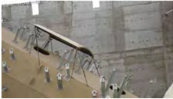
Εικόνα 98. Λεπτομέρεια τοποθέτησης φύλλου λαμαρίνας επάνω στις ρυθμιστικές ακίδες του οκταγωνικού πυρήνα
