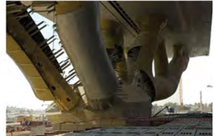
Εικόνες 114 & 115. Τα τελικά στάδια μορφοποίησης του κελύφους των κλαδιών λίγο πριν από τη σκυροδέτηση της πλάκας του υπόστεγου. Φωτογραφίες από το εργοτάξιο
