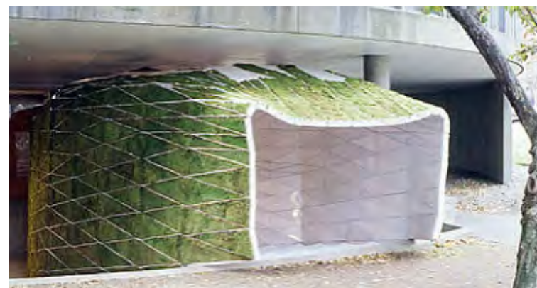
Εικόνα 2. Το κοιτοβόθαι στο Carpenter Centre for the Visual Arts
