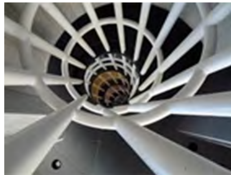
Εικόνα 80. Τογο Ito. Τα υποστυλώματα στην βιβλιοθήκη Sendai Mediatheque
