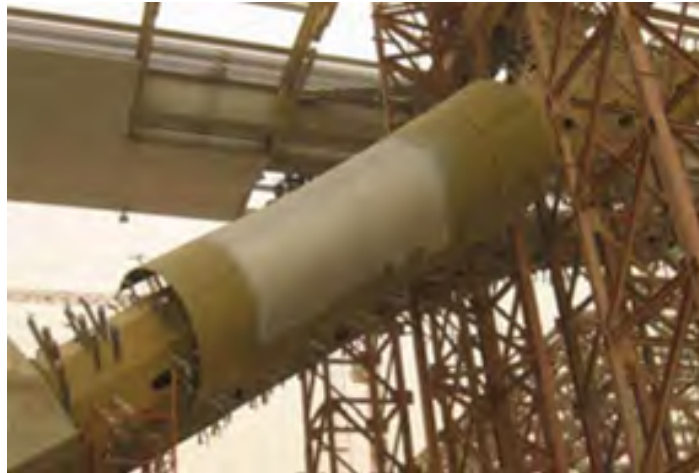
Εικόνες 114 & 115. Τα τελικά στάδια μορφοποίησης του κελύφους των κλαδιών λίγο πριν από τη σκυροδέτηση της πλάκας του υπόστεγου. Φωτογραφίες από το εργοτάξιο
