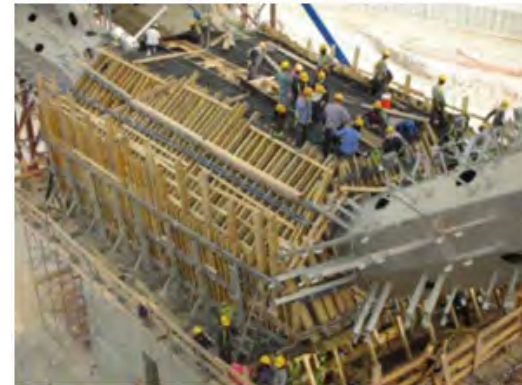
Εικόνα 113. Έγχυση σκυροδέματος στον κόμβο σύνδεσης των κλαδιών. Φωτογραφία από το εργοτάξιο
