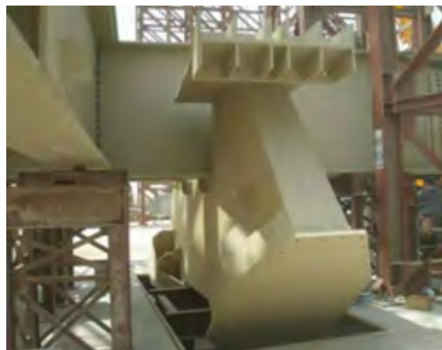
Εικόνα 70. Η μεταλλική βάση των δενδροειδών στοιχείων της πρόσοψης
