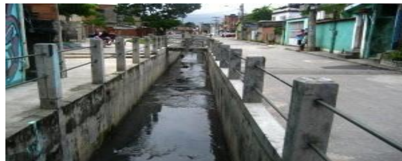
Εικ. 2-7: Επίλυση αποχετευτικού προβλήματος στο εσωτερικό της φαβέλας Acari, στα πλαίσια του προγράμματος Favela Bairro. Διαμόρφωση καναλιού που περνάνε τα λύματα.
