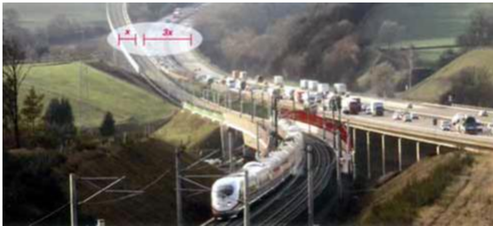
Εικόνα 2: Εύρος κατάληψης διπλής σιδηροδρομικής γραμμής και αυτοκινητόδρομου [6]
