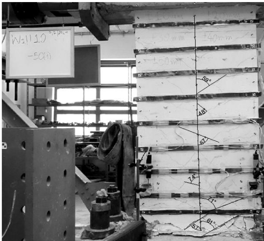
Εικόνα 7.45 Γωνίες ρηγμάτωσης καθ' ύψος του δοκιμίου κατά τη θραύση εφελκόμενης ράβδου
