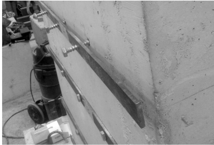
Εικόνα 6.10 Διάνοξη οπών στις λάμες πριν την επικόλληση στο δοκίμιο W8
