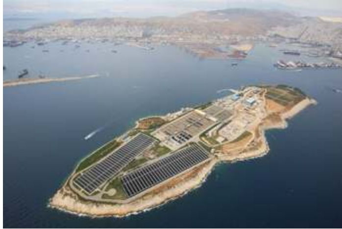
Εικόνα 2: Κέντρο Επεξεργασίας Λυμάτων Ψυττάλειας ( www.evdap.gr )
