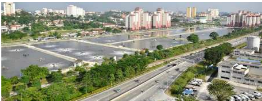
Εικόνα 6: Υπόγειο κέντρο επεξεργασίας λυμάτων Pantai2-Υπάρχουσα κατάσταση
