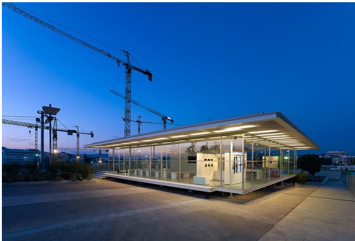
Εικόνα 44 - Το Κέντρο Επισκεπτών, που βρίσκεται στα όρια του εργοταξίου, στην αρχή της Εσπλανάδας. Προσφέρει την ευκαιρία στο κοινό να ενημερωθεί για την κατασκευή του ΚΠΙΣΝ, τις μελλοντικές του δραστηριότητες, ενώ φιλοξενεί πλήθος εκδηλώσεων. Συνιστά χαρακτηριστικό δείγμα της εξωστρέφειας που εναργερίζεται το έργο. (Πηγή: http://www.snfcc.org/multimedia/construction-photos/?lang=el )
