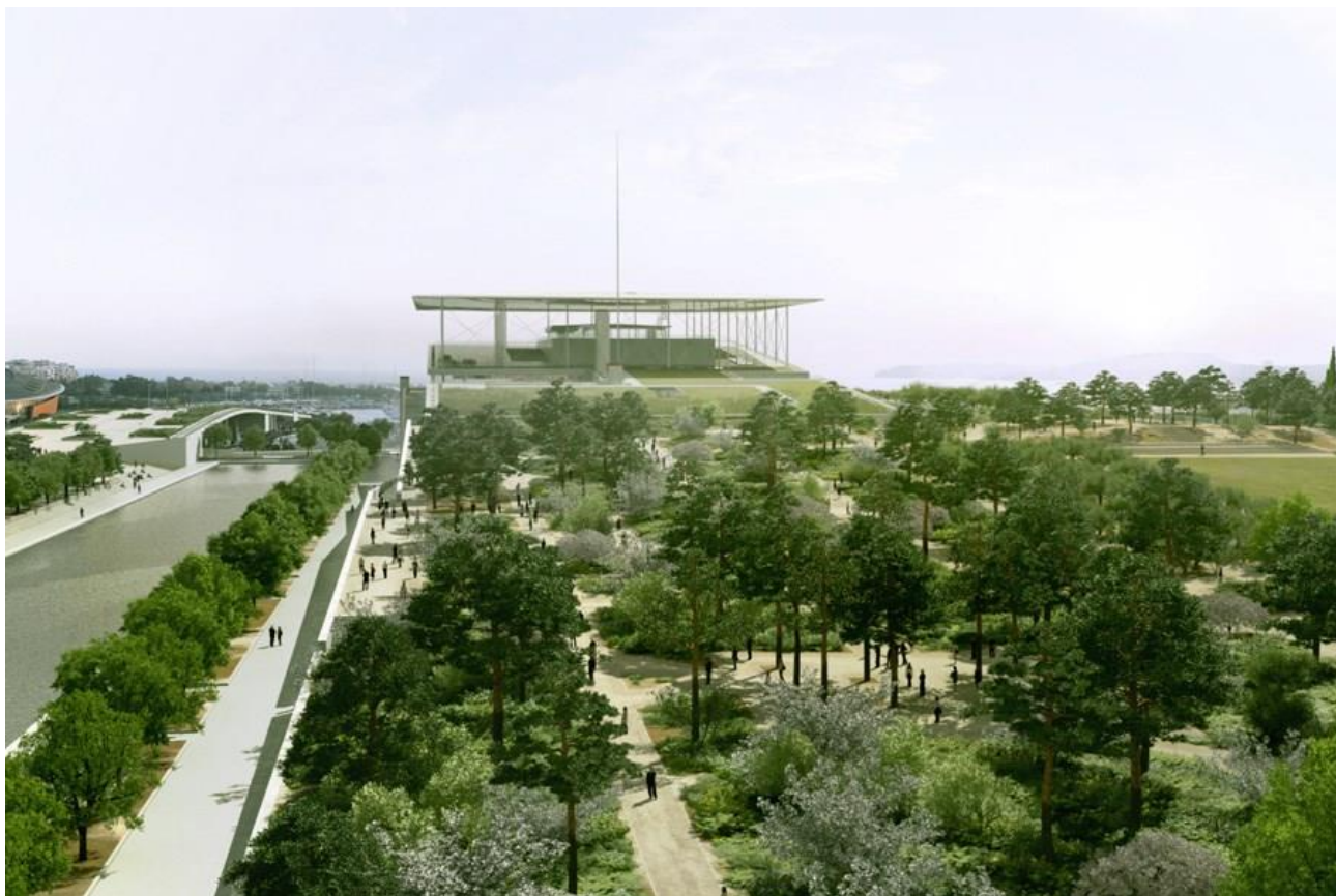
Εικόνα 15 - Άποψη του Πάρκου και του κτιριακού συγκροτήματος από τη βόρεια πλευρά του ΚΠΙΣΝ. (Πηγή: http://www.snfcc.org/multimedia/construction-photos/?lang=el )
