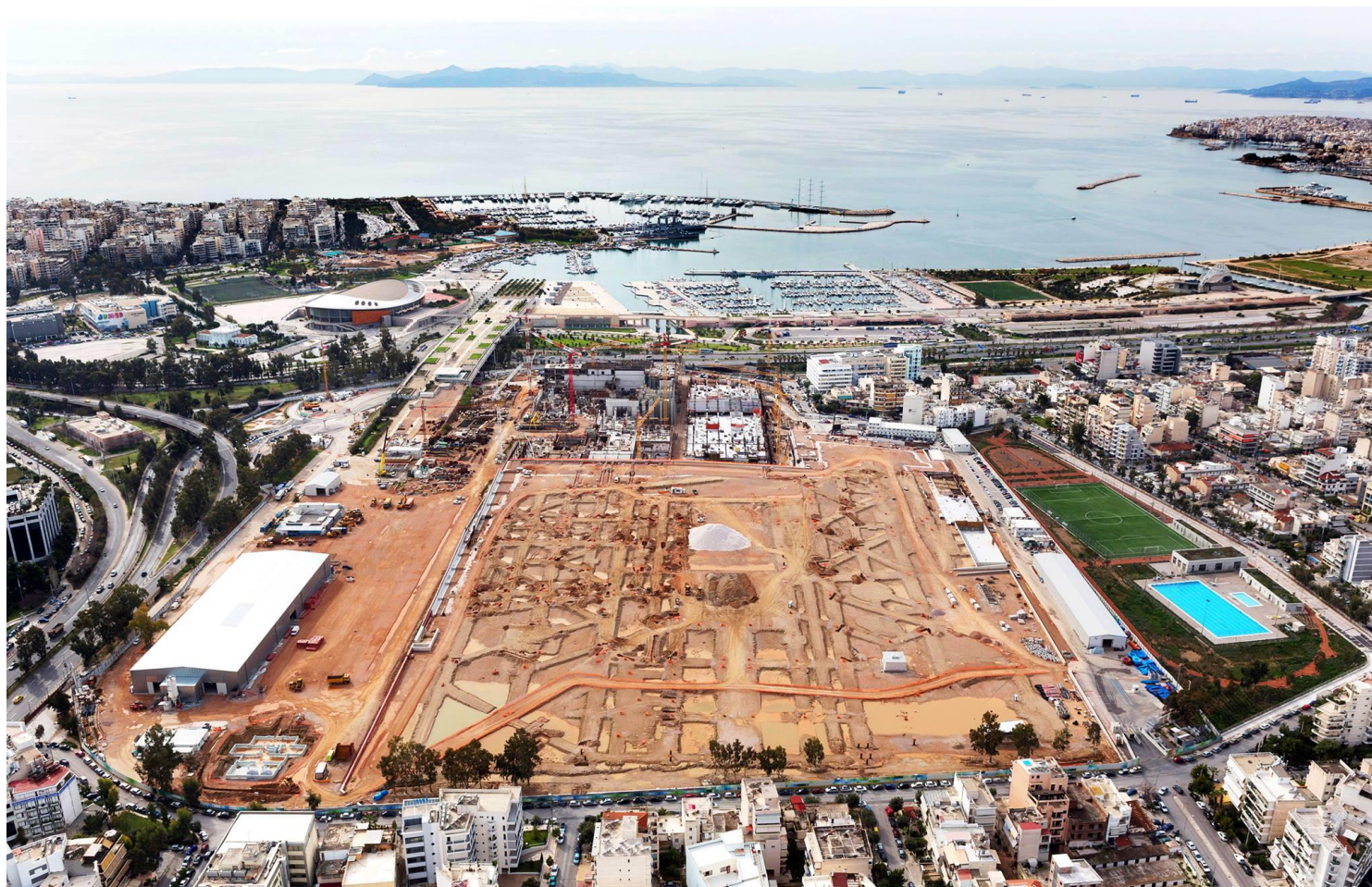
Εικόνα 45 – Οπτική του εργοταξίου και της ευρύτερης περιοχής από τη βόρεια πλευρά του έργου. Η μεταμόρφωση της πόλης εν εξελίξει. Ημερομηνία φωτογράφισης: Φεβρουάριος 2014. (Πηγή: Χρυσόστομος Φουντής, JV Impregilo – TERNA)
