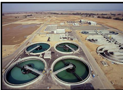
Σχήμα 3.1. : Εγκατάσταση επεξεργασίας λυμάτων (Roseville, Καλιφόρνια)
