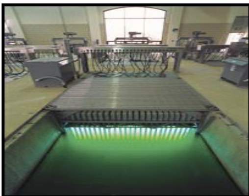
Σχήμα 3.6. : Απολύμανση με υπεριώδη ακτινοβολία
