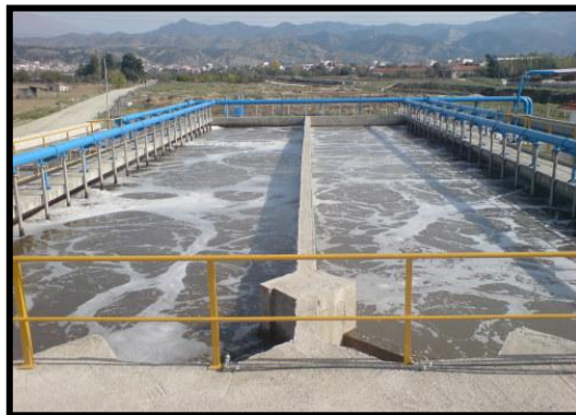
Σχήμα 3.5. : Δεξαμενή αερισμού
