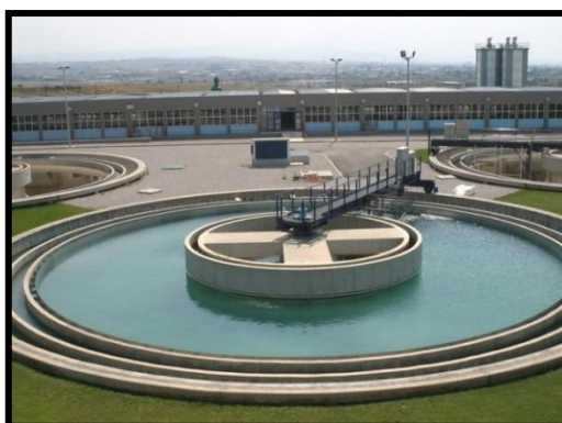
Σχήμα 3.4. : Κυκλική δεξαμενή καθίζησης
