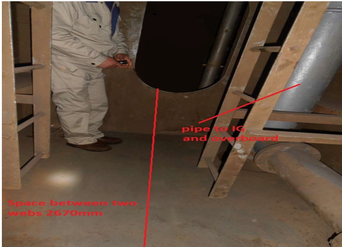
Εικόνα 4.13: Χώρος ανάμεσα στα 2 web frames
