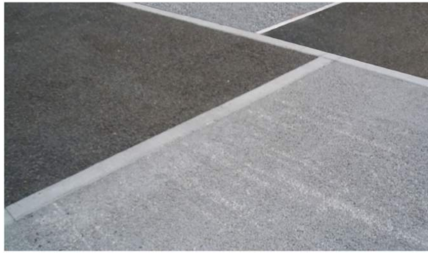
εξωτερικά δάπεδα διαπερατό σκυρόδεμα
