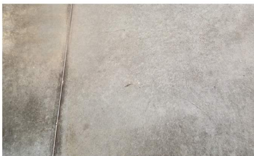
τοιχεία από ανεπίχρηστο σκυρόδεμα εσωτερικά δάπεδα από γυαλισμένο σκυρόδεμα
