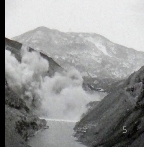
Η κατασκευή του φράγματος των Κρεμαστών άρχισε το 1961 (φωτ. ΔΕΗ)
