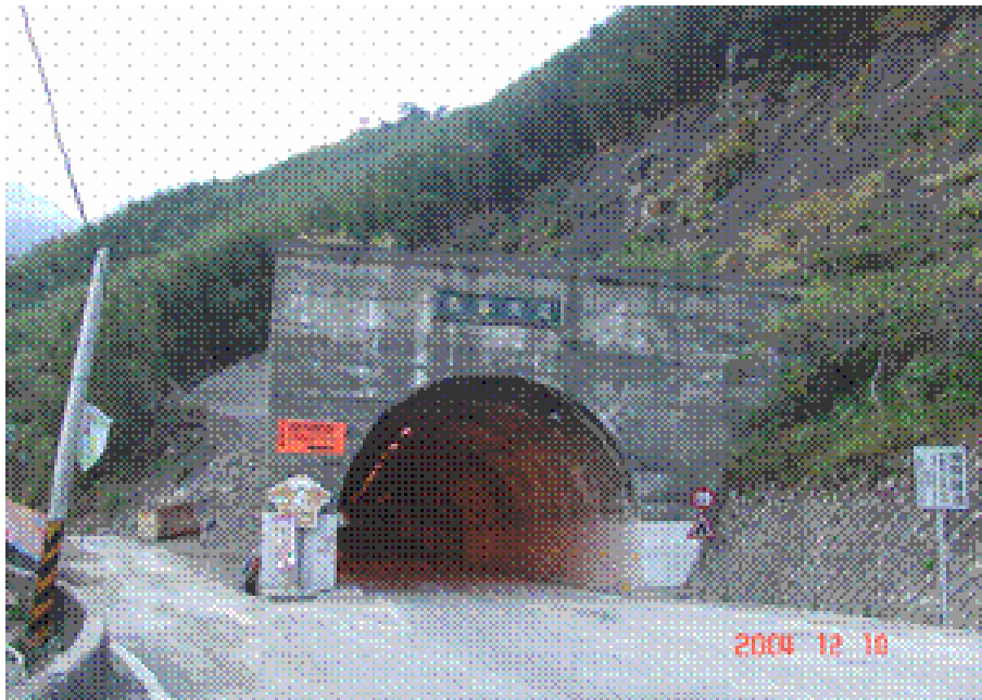
Φωτογραφία 6.14. Σήραγγα Hsueh Wu. Photograph 6.14. Hsueh Wu tunnel.
