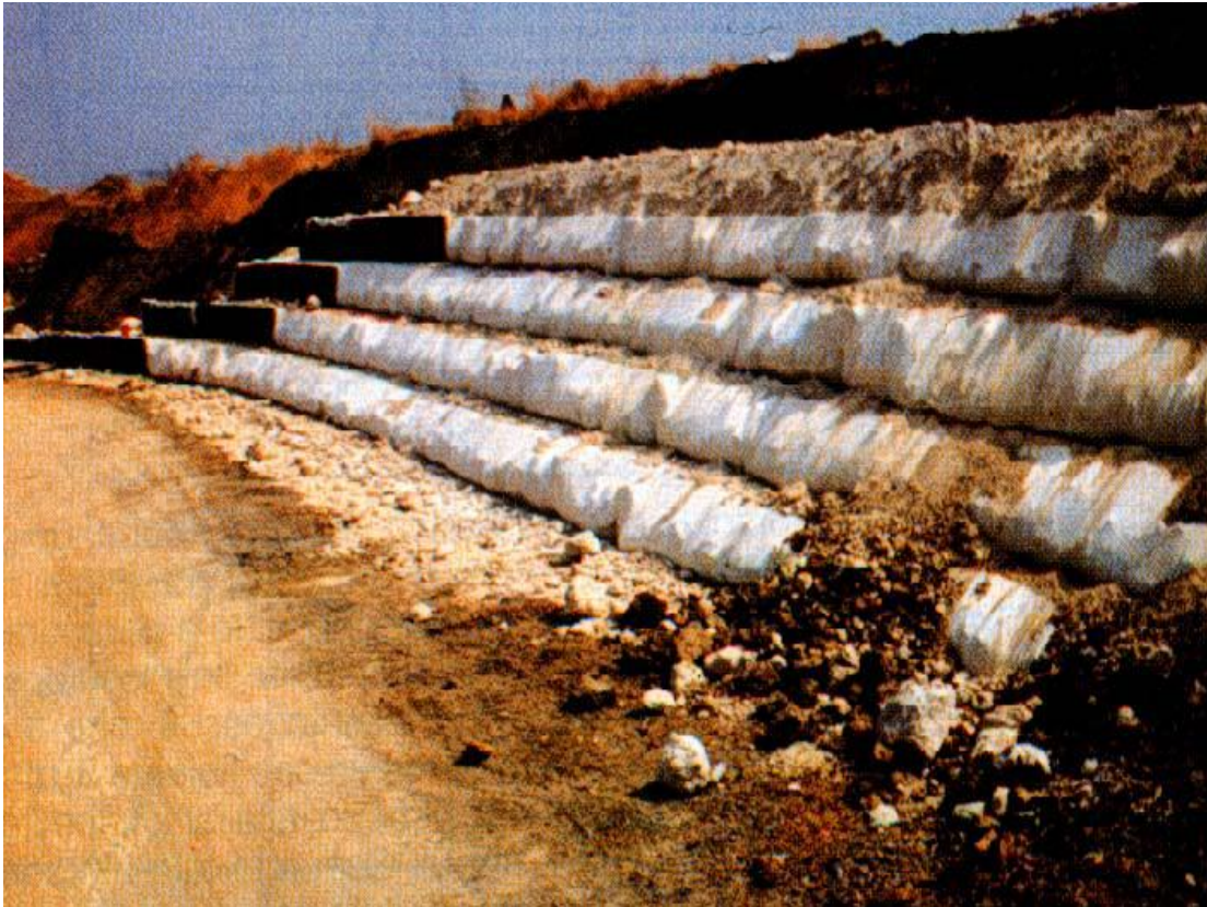
Φωτογραφία 1.11. Εφαρμογές Γεωφασμάτων σε τεχνικά έργα. Photograph 1.11. Implementation of Geotextiles in technical constructions.
