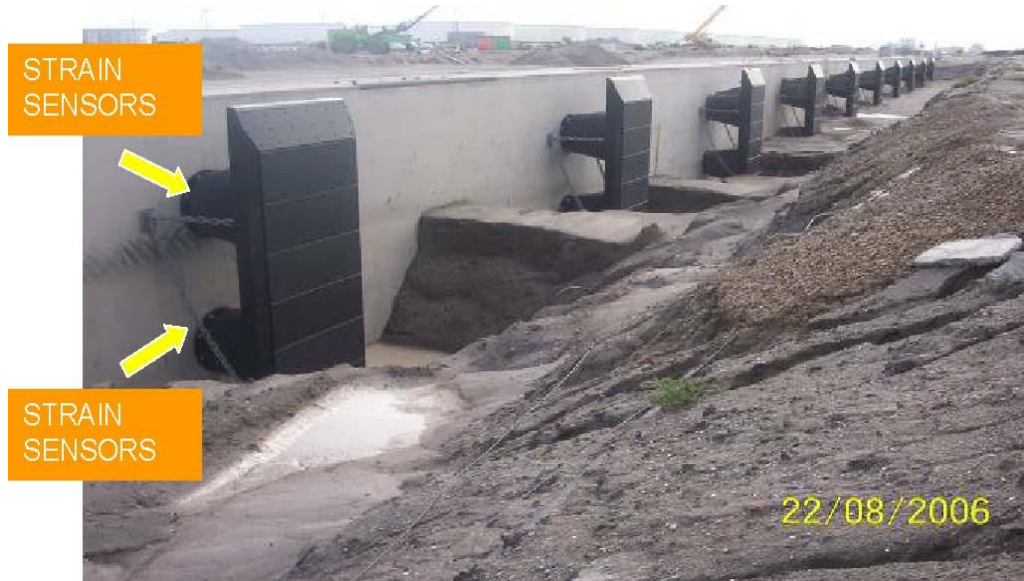
Φωτογραφία 6.13. Αισθητήρες οπτικών ινών προσαρτημένες σε 24 ελαστικούς προφυλακτήρες. Figure 6.13. Strain sensors mounded on a series of 24 fenders.
