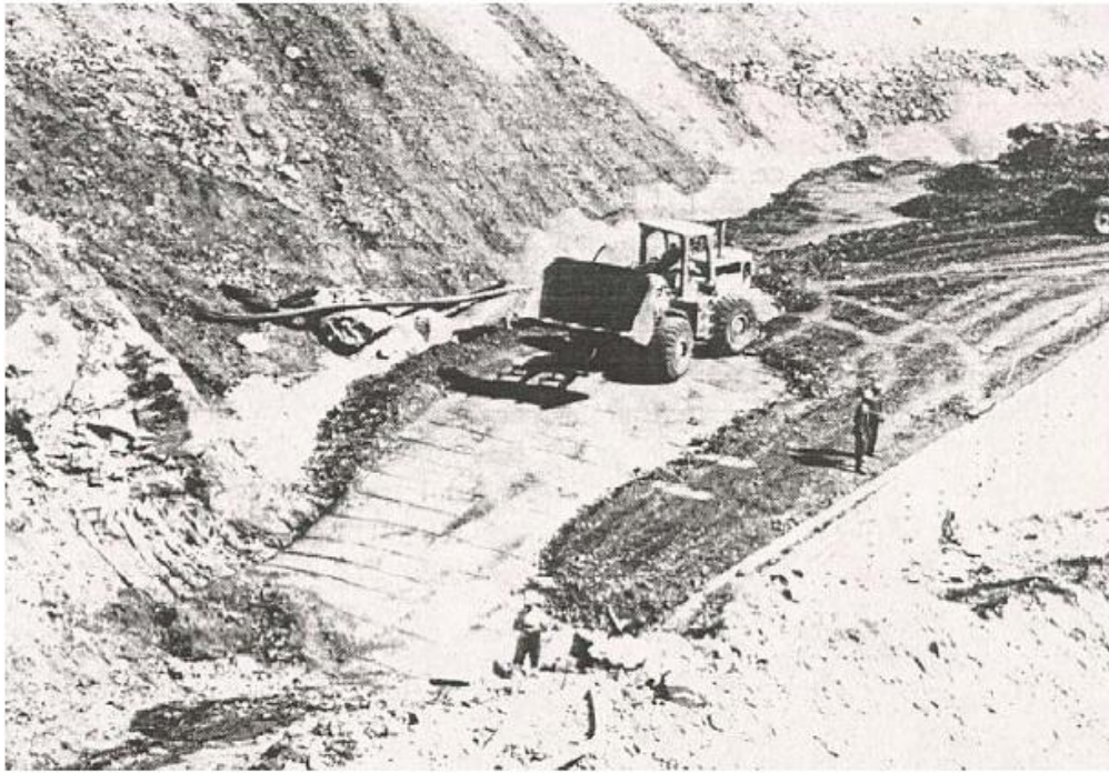
Φωτογραφία 1.6. Πρώτος οπλισμένος τοίχος στις ΗΠΑ (Mitchell et al. 1987). Photograph 1.6. First reinforced wall in the United States (Mitchell et al. 1987).
