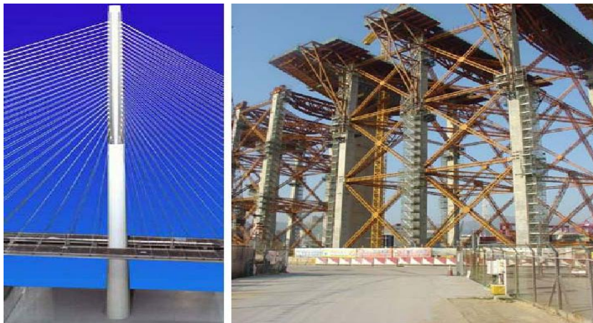
Φωτογραφία 6.11. Καλωδιωτή γέφυρα Stonecutters στο Hong Kong. Photograph 6.11. Stonecutters cable bridge in Hong Kong.
