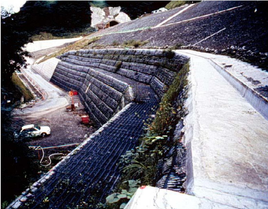
Φωτογραφία 1.15. Εφαρμογές Γεωπλέγματος σε τεχνικά έργα. Photograph 1.15. Implementation of Geogrid in technical constructions.
