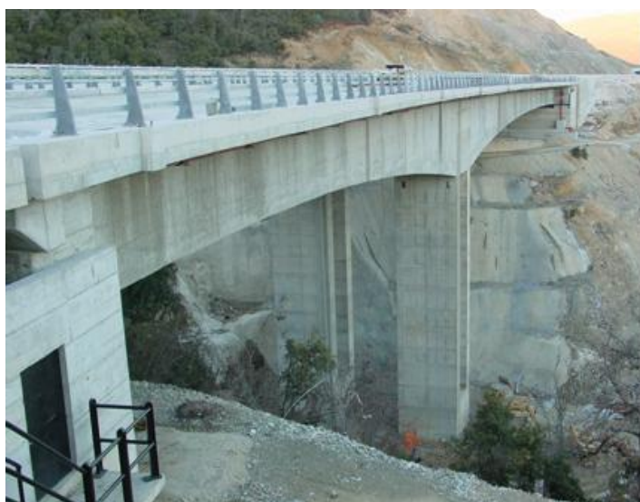
Φωτογραφία 6.19. Γέφυρα Γ9 Εγνατίας Οδού. Photograph 6.19. G9 Bridge of Egnatia Highway.
