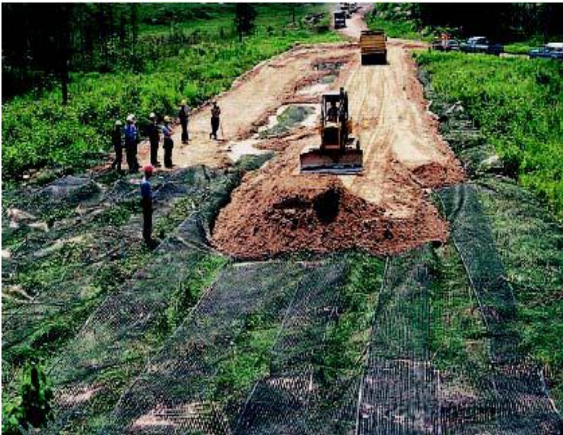
Φωτογραφία 1.14. Εφαρμογές Γεωπλέγματος σε τεχνικά έργα. Photograph 1.14. Implementation of Geogrid in technical constructions.
