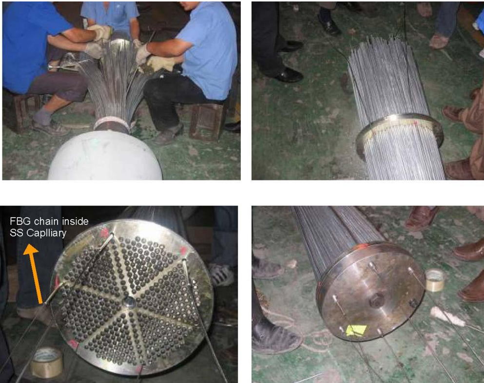
Φωτογραφία 6.12. Τοποθέτηση αισθητήρων οπτικών ινών στο εσωτερικό των καλωδίων. Figure 6.12. Placement of optical fibre sensors inside the stay cables.
