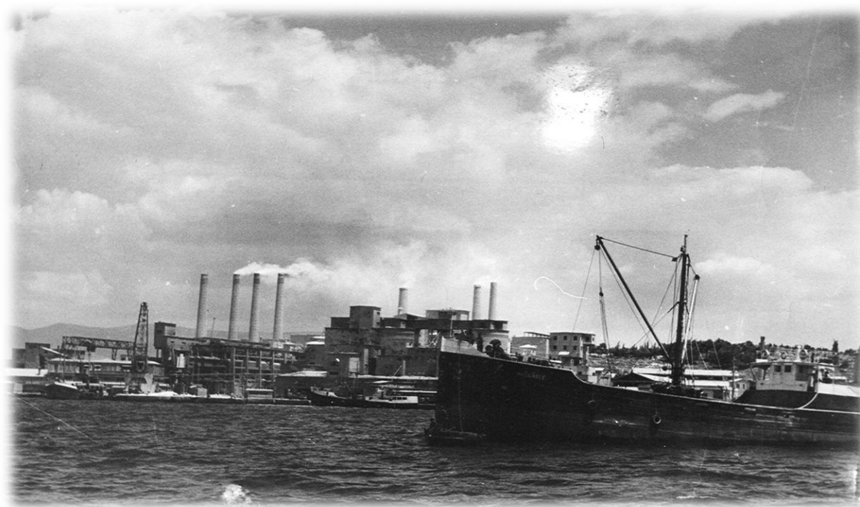
Εικόνα 10: Εργοστάσιο Τιτάν από θάλασσα (1902)
