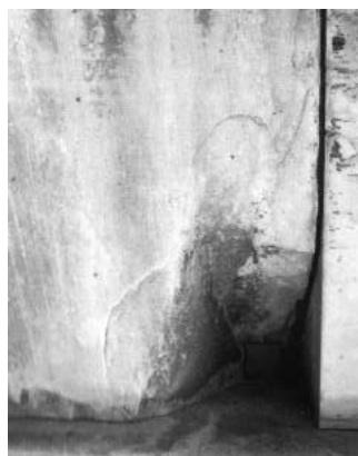
Εικ. 1.11: Αστοχία σε γόμφωση με θραύση του μαρμάρου στην περιοχή της αγκύρωσης [6].
