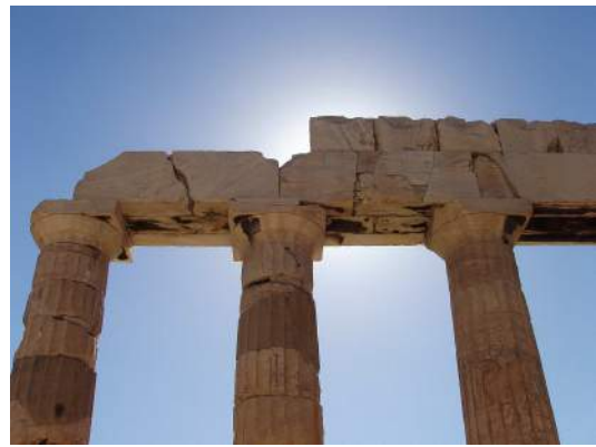
Εικ. 4.11: Μία τοπική σύνδεση δύο εν σειρά επιστυλίων. Διακρίνεται καθαρά ο άβακας.
