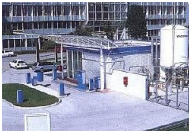
Εικόνα 2-6: Οι εγκαταστάσεις της μονάδας ηλεκτρόλυσης νερού, Solar Wasserstoff Bayern (SWB)
