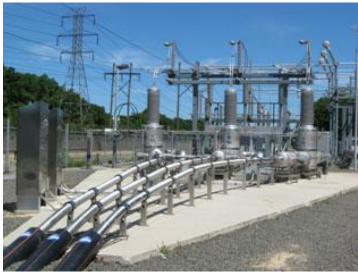
Σχ. 1.29 Δίκτυο υπεραγωγίων καλωδίων τάσης 138 kV [1.48]
