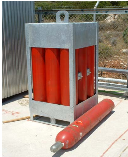
Εικόνα II.1.9: Συμβατική δεξαμενή υδρογόνου (buffer)
