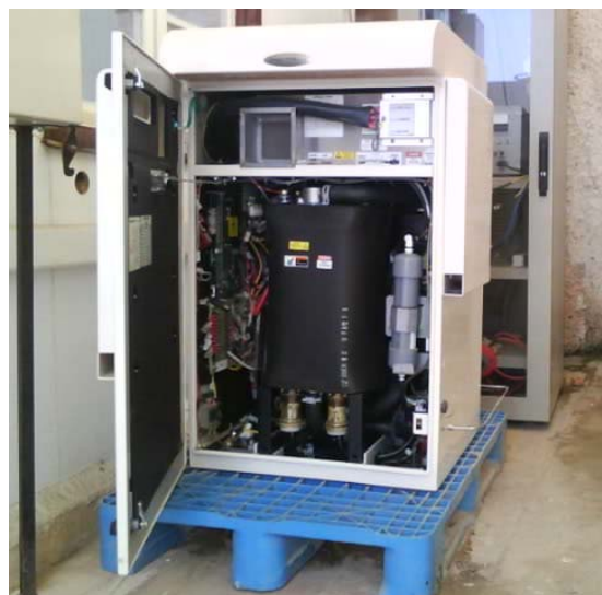
Εικόνα II.1.5: Κυψέλη Καυσίμου τεχνολογίας μεμβράνης εναλλαγής πρωτονίων (PEM)
