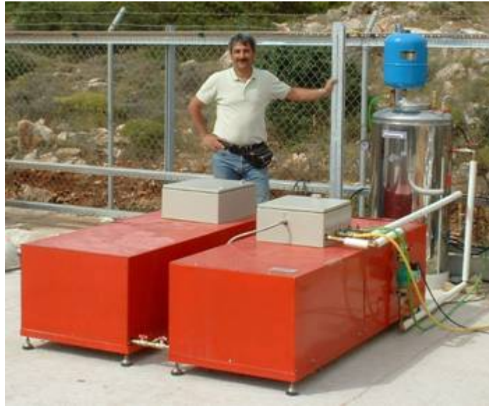
Εικόνα II.1.12: Δεξαμενή μεταλλοϋδριδίων
