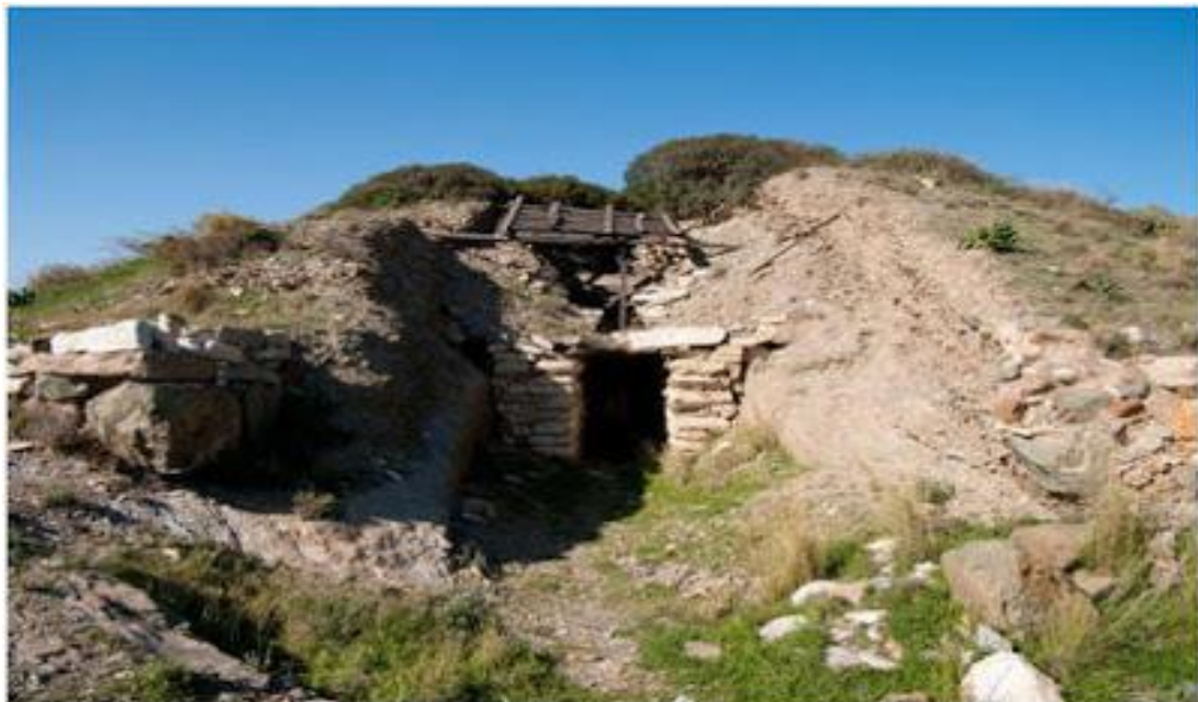
Εικόνα 5.4: Η αρχαιότερη μεταλλευτική στοά της περιοχής της ΝΑ Αττικής. Η στοά αυτή βρίσκεται στο λόφο Βελατούρι στην περιοχή του Θορικού και χρονολογείται στο 3000 π.Χ.
