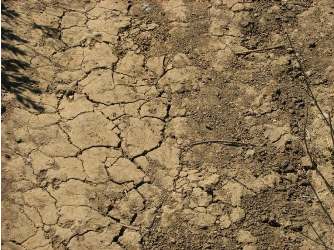
Εικόνα 53: Έδαφος που έχει υποστεί διόγκωση
