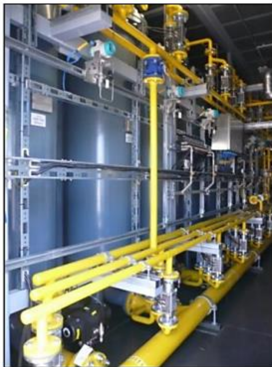
Εικόνα 5.35: Μονάδα διαχωρισμού CH 4 / CO 2 μέσω απορρόφησης με εναλλαγή πίεσης έξι δοχείων (Severn Wye Energy Agency)
