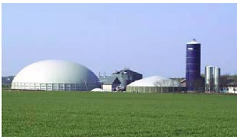
Εικόνα 4.3: Εγκατάσταση βιοαερίου κλίμακας αγροκτήματος στη Δανία, για συγχώνευση ζωικών πολτών και ενεργειακών καλλιεργειών ( groengas.nl )
