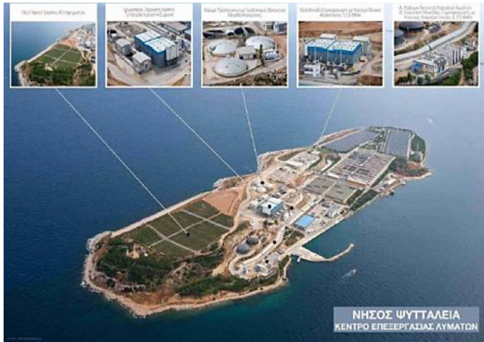
Εικόνα 4.15: Μονάδα βιοαερίου στη Ψυττάλεια δυναμικότητας 11,4 MW ( www.rae.gr )
