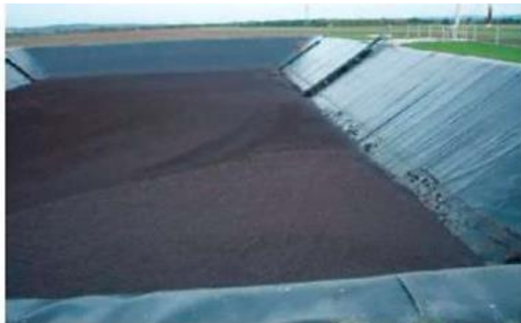
Εικόνα 5.27: Ανοικτές τεχνητές λίμνες για την αποθήκευση του κομπόστ (AGRINZ GmbH, 2006)
