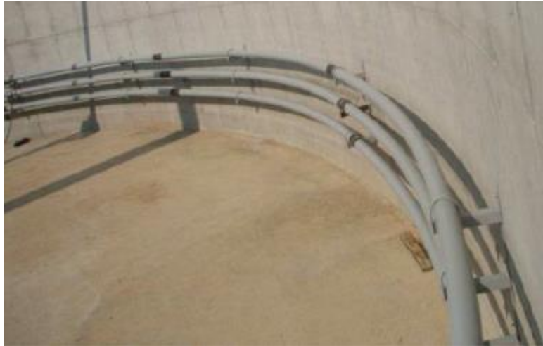
Εικόνα 5.18: Σωληνώσεις θέρμανσης εγκαταστημένες στον χωνευτήρα (AGRINZ GmbH, 2008).
