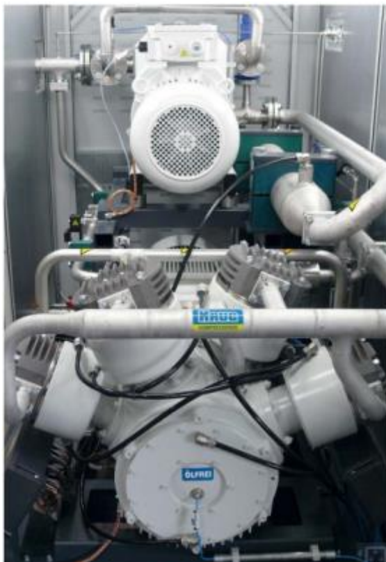
Εικόνα 5.34: Συμπιεστής της μονάδας αποθείωσης ισχύος 60kW της εταιρίας HAUG ( www.haug.ch )
