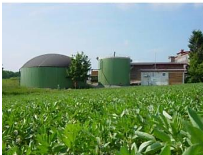
Εικόνα 4.4: Εγκατάσταση βιοαερίου στη Γερμανία, που επεξεργάζεται κοπριές από χοίρους, πουλκερικά και σωρούς χόρτων ( www.kriegfischer.de )
