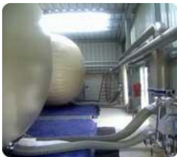
Εικόνα 5.29: Συστήματα αποθήκευσης βιοαερίου (Severn Wye Energy Agency)
