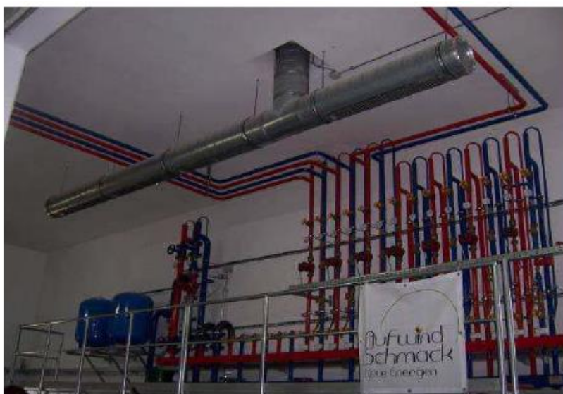
Εικόνα 5.17: Σύστημα θέρμανσης μιας εγκατάστασης βιοαερίου (RUTZ, 2008).
