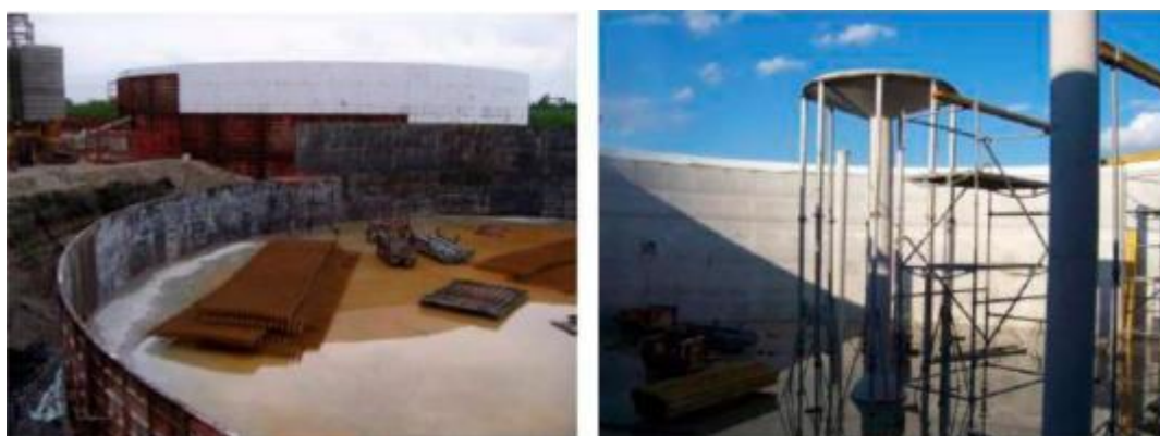
Εικόνα 5.13: Επιτόπου κατασκευή κατακόρυφων χωνευτήρων από σκυρόδεμα (RUTZ,2008)
