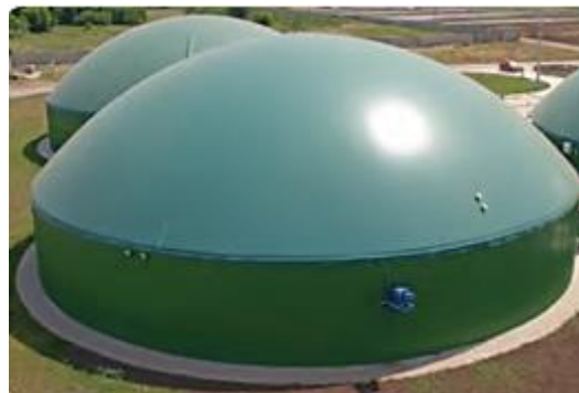
Εικόνα 4.9: Σύστημα αποθήκευσης βιοαερίου ((Γιακουμέλος Α. 2012)
