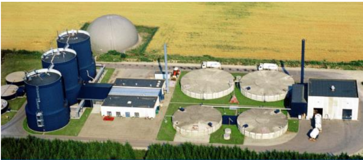
Εικόνα 4.11: Εγκατάσταση μονάδας βιοαερίου στη Δανία ( www.lemvigbiogas.dk )
