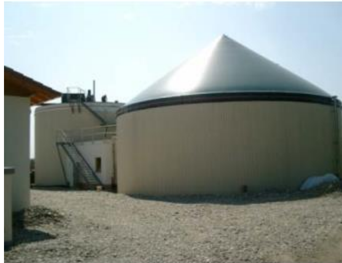
Εικόνα 4.5: Εγκατάσταση βιοαερίου στη Γερμανία που κατασκευάστηκε το 2005 για τη χώνευση ενεργειακών καλλιιεργειών ( www.kriegfischer.de )
