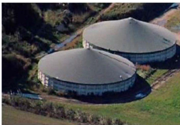
Εικόνα 5.26: Δεξαμενές αποθήκευσης καλυμμένες με μεμβράνες (AL SEADI, 2008).
