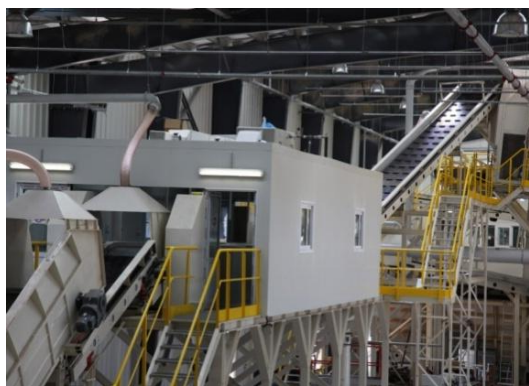
Εικόνα 39: Εικόνα από τις εγκαταστάσεις στο ΚΔΑΥ Κορωπίου
