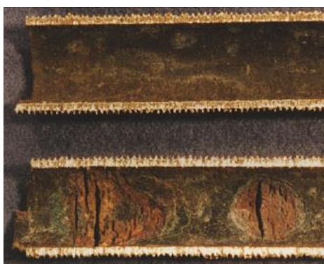
Σχήμα 1.27: Ρωγμές από διάβρωση λόγω κόπωσης σε ορειχάλκινο σωλήνα συμπίκνωσης νερού 57
