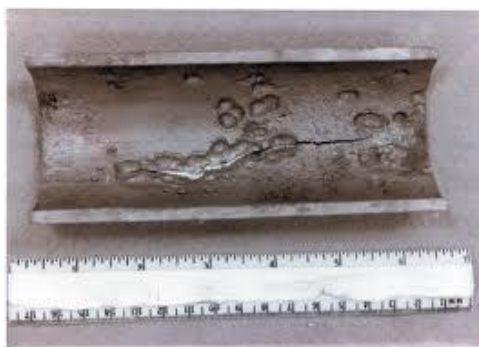
Σχήμα 1.16: Διάβρωση με βελονισμούς σε μεταλλικούς αγωγούς 41
