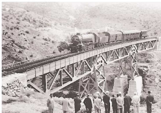
Εικόνα 2.5: Γέφυρα διαδρομής Αθήνα-Λάρισα
