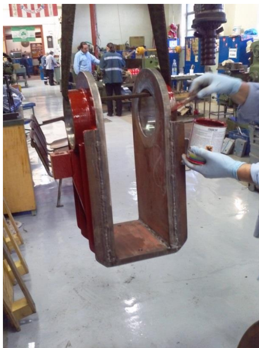
Εικόνα 8.20: Επάλειψη τεμαχίων με αστάρι
