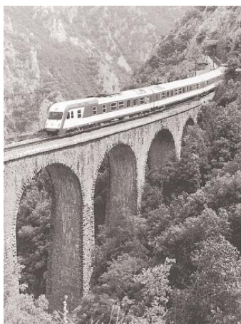
Εικόνα 2.9: Η αμαξοστοιχία Intercity στη γέφυρα του Μπράλου
