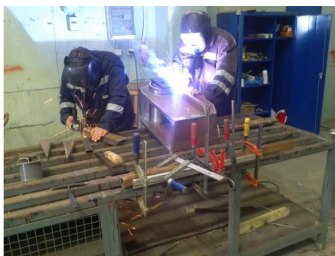
Εικόνα 8.12: Συγκόλληση δεξιού ενισχυτικού πλαϊνής πλάκας φορέα φόρτισης
