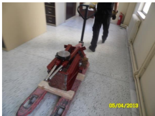
Εικόνα 8.47: Μεταφορά φορέα φόρτισης και ορθοστατών
