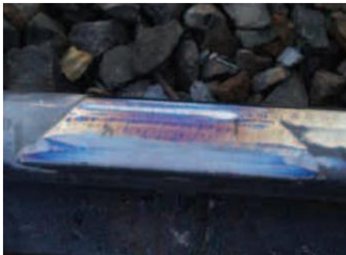
Σχήμα 4.8(β): Μεταλλική επιφάνεια μετά από αναγόμωση και λείανση
