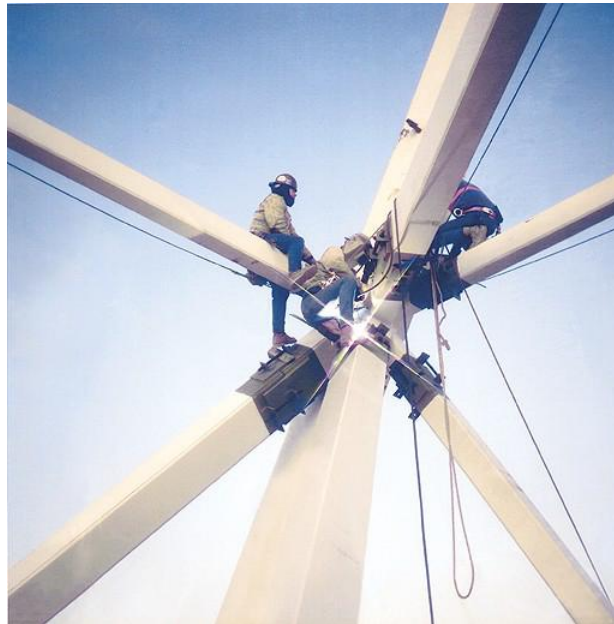
Σχήμα 1.11: Ένα από τα πλεονεκτήματα της SMAW είναι η δυνατότητα εργασίας σε σημεία δύσκολα προσβάσιμα
