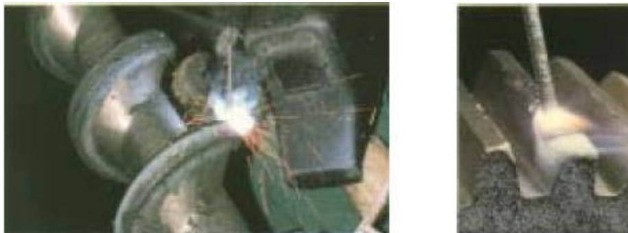
Σχήμα 4.3: (1) Αναγόμωση πτερυγίων μεταφορικού κοχλίου (2) Αναγόμωση οδοντωτού τροχού
