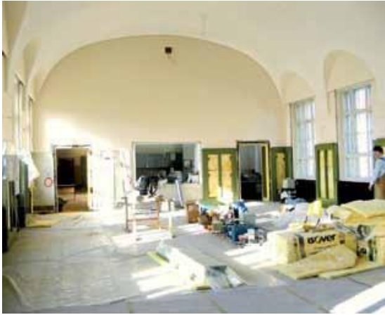
Εικόνα 4.9 Εργασίες ανάπλασης εσωτερικού χώρου σχολείου
