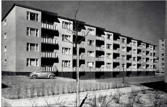
Εικόνα 3.12 Πολυκατοικίες που προέκυψαν στο δυτικό Βερολίνο μετά το 1950
