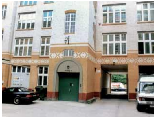
Εικόνα 4.12 Μετατροπή του χώρου σε κατοικίες Loft
