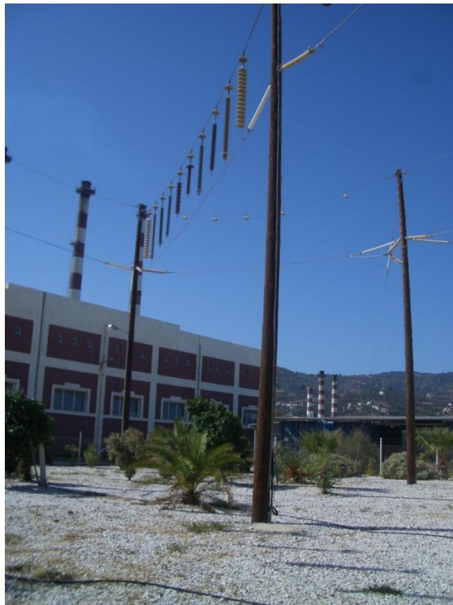
5. Εδώ θα τοποθετηθεί η συσκευή DI-722-32.
