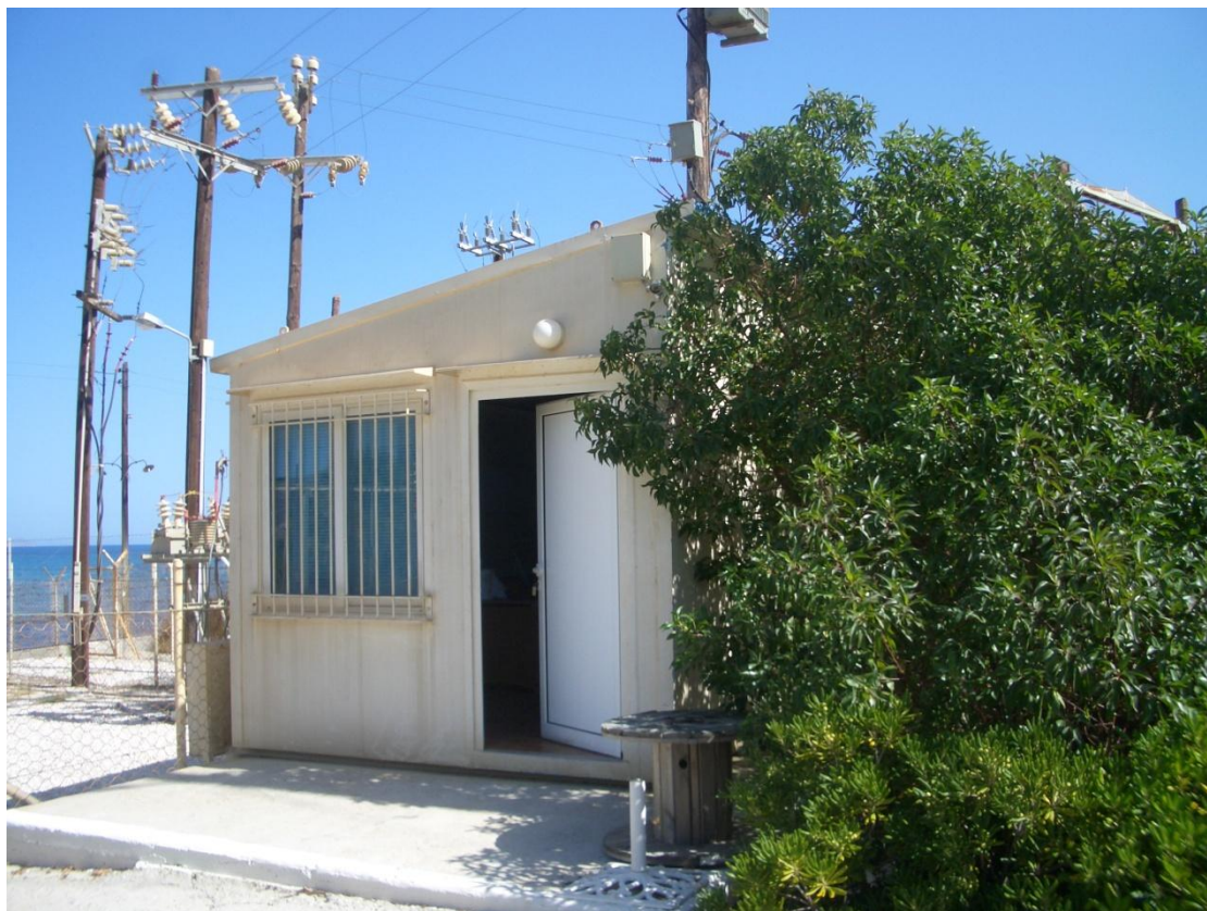
6. Οικίσκος ελέγχου όλου του Σταθμού Δοκιμών.
