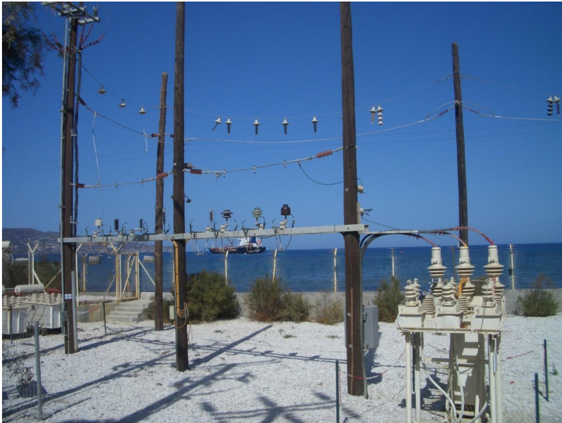
6. Μονωτήρες στηρίξεως και αναρτήσεως (τμήμα 20kV).
