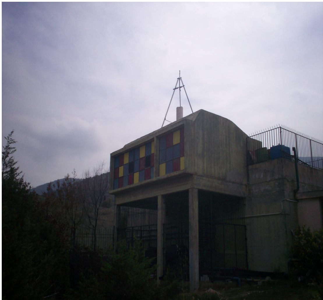
Εικόνα 20: Το βάθρο στο αντλιοστάσιο
