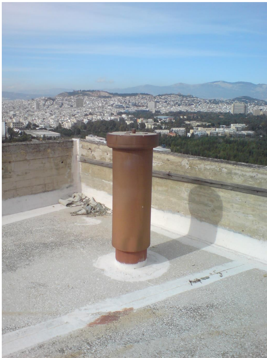
Εικόνα 14: Το βάθρο στο κτήριο των παλαιών εστιών
