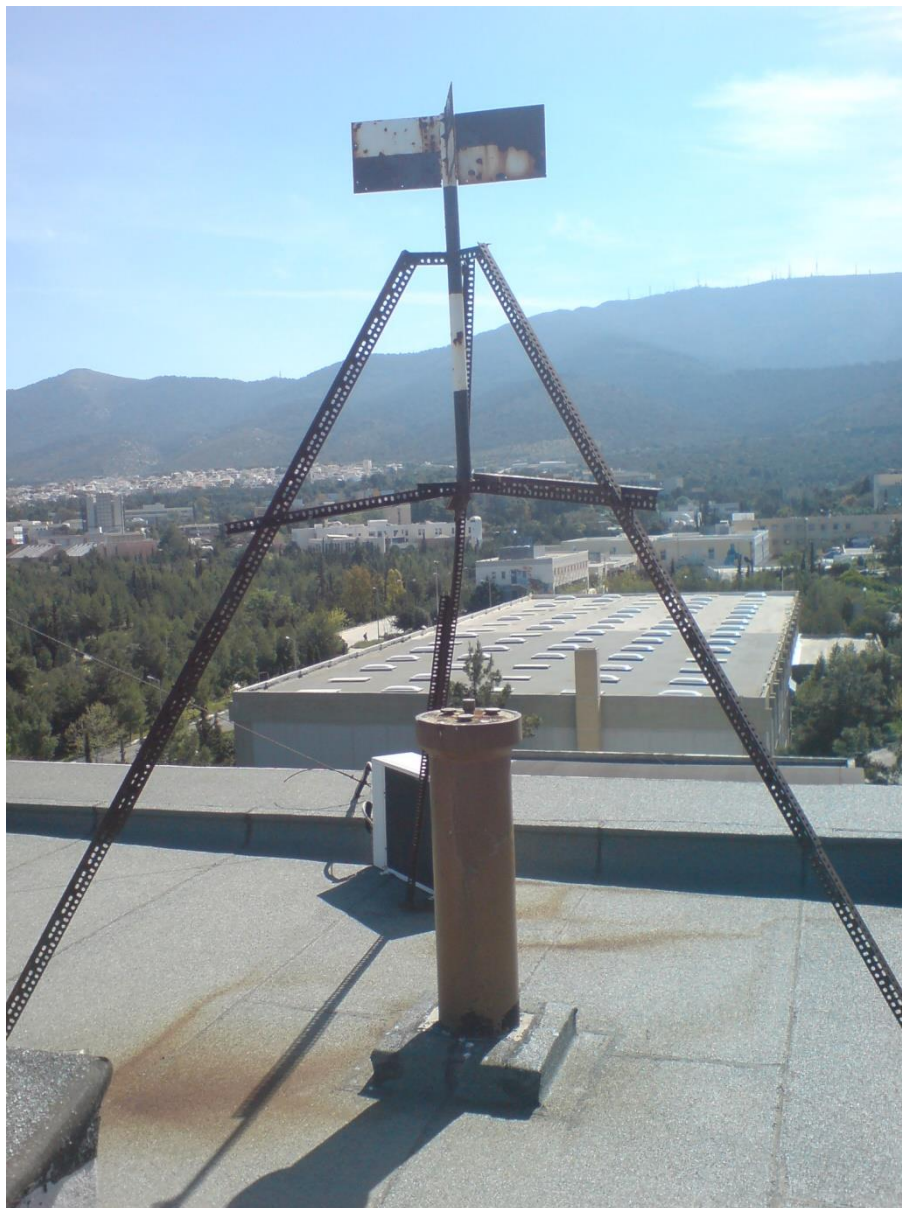
Εικόνα 13: Το βάθρο στο κτήριο της Υδραυλικής
