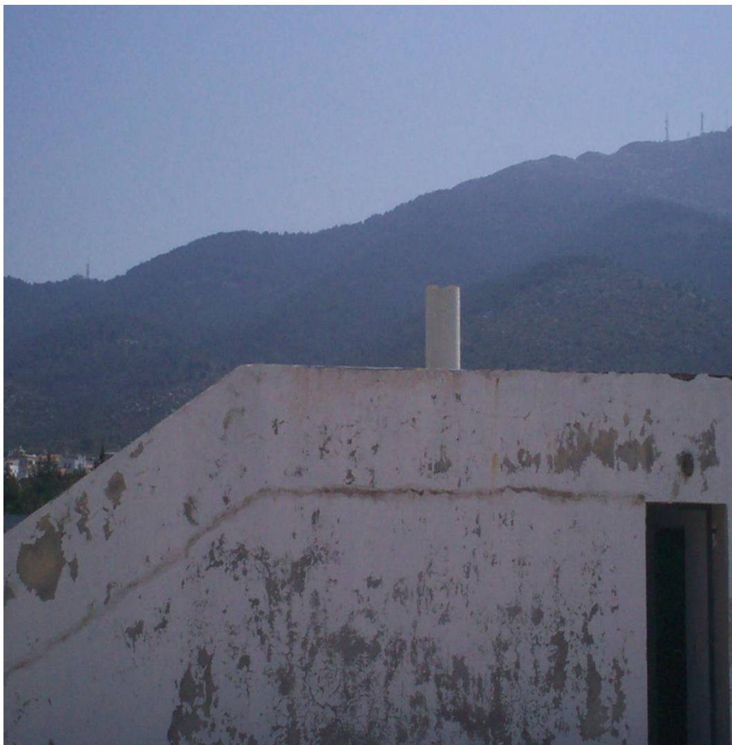
Εικόνα 16: Το βάθρο στο δώμα του κτηρίου ΣΕΜΦΕ (Παλιές Γενικές Έδρες)
