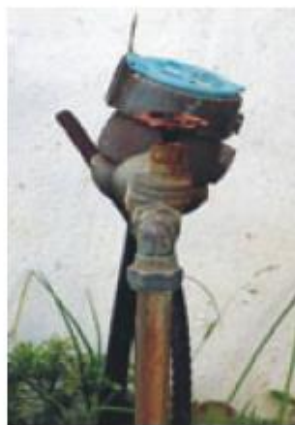
εικόνα 4.5-4 εσφαλμένη εγκατάσταση, αυξημένη επαφή
