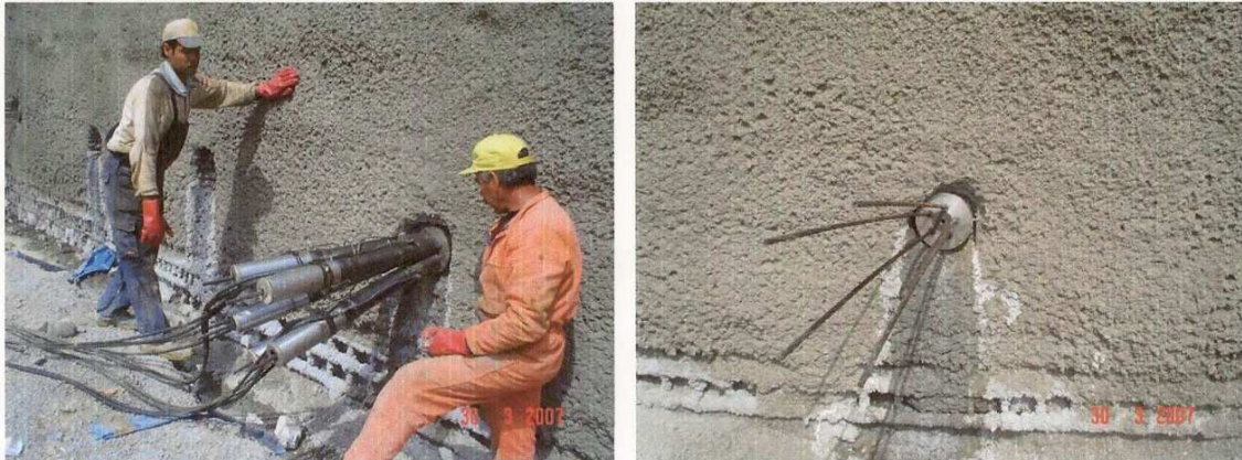
Σχήμα 1.13: Προένταση αγκυρίου επί φρεατοπασσάλων (κατά Χ.Ζερβογιάννη 2008).
