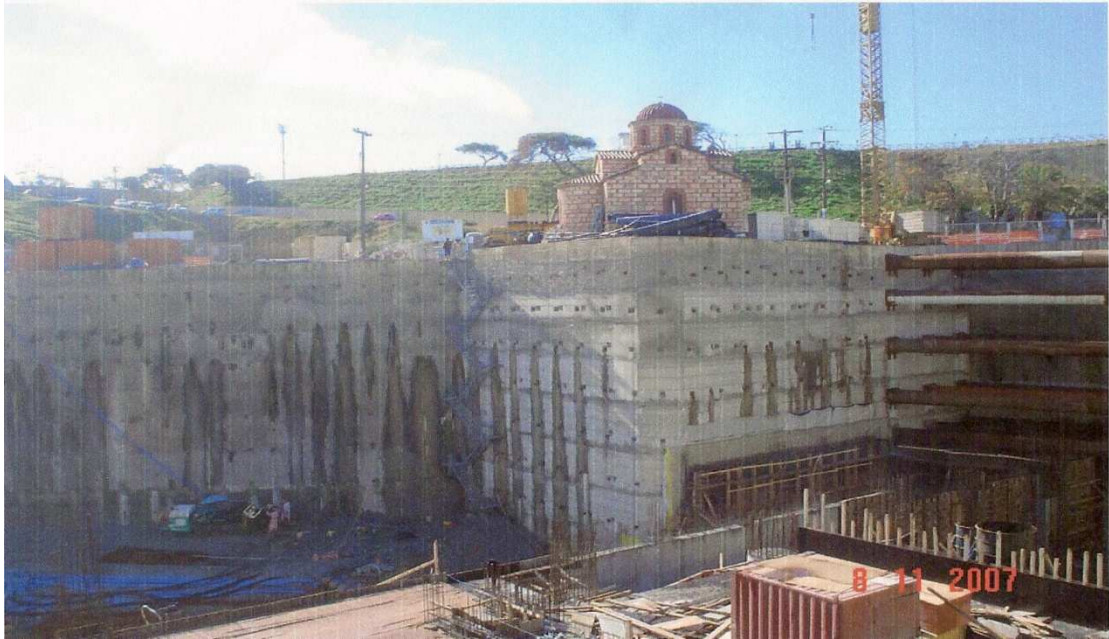
Σχήμα 1.15: Εργοτάξιο σε φάση ολοκλήρωσης της γενικής εκσκαφής (ανάδοχος αντιστηρίξεων ΕΔΡΑΣΗ-Χ.ΨΑΛΙΔΑΣ Α.Τ.Ε.).
