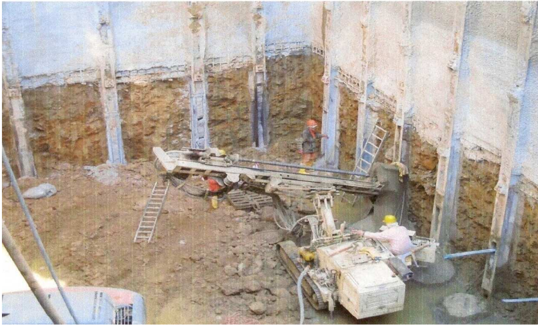
Σχήμα 1.7:Εικόνα από την κατασκευή αγκυρίων επί σιδηροπασσάλων.
