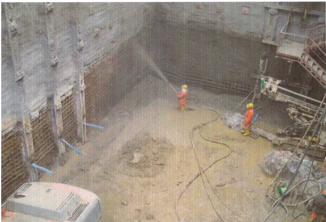
Σχήμα 1.8:Εικόνα εργοταξίου σε εξέλιξη.
