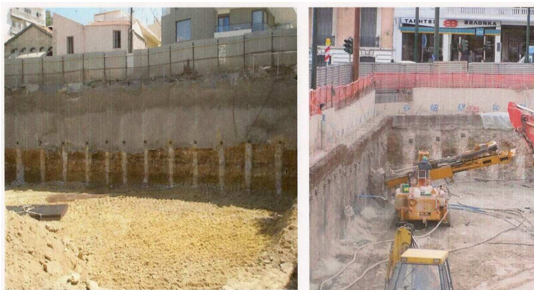
Σχήμα 1.12: Εργοτάξια αντιστήριξης σε αστικό χώρο με αγκυρωμένους φρεατοπασσάλους.
