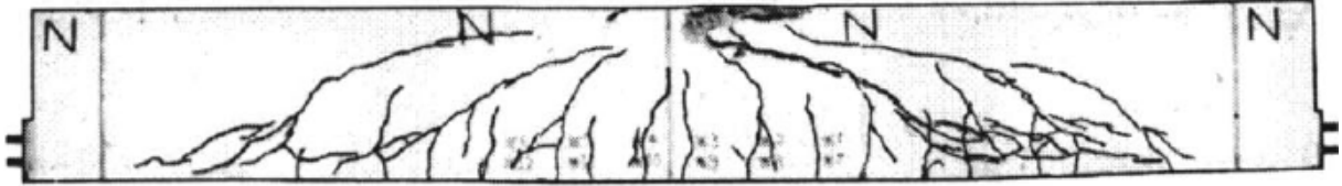
Σχήμα 4.84: Ρηγμάτωση (crack pattern) της δοκού A1 στο στάδιο αστοχίας κατά την πειραματική δοκιμή [10].
