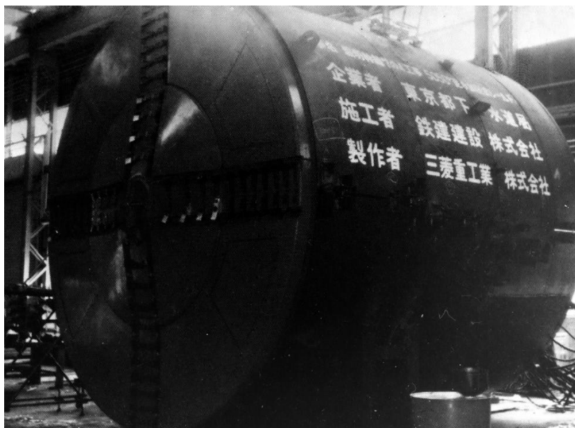
Εικόνα 1-24: Το πρώτο μηχάνημα πολφού μπετονίτη Ιαπωνικού τύπου [12]
